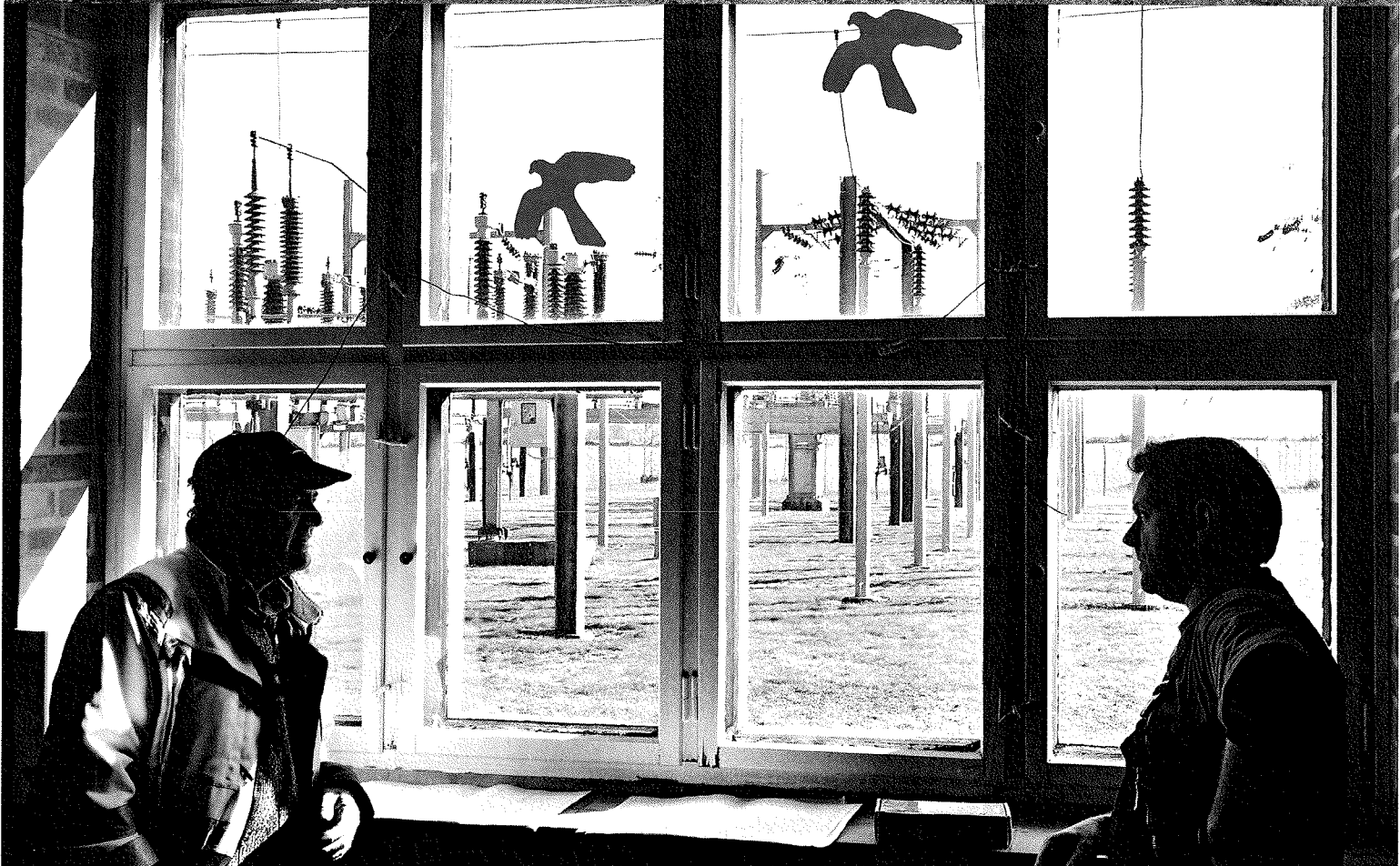
Øverst: 60 kV friluftanlæg på 60/10 kV station Møllemose Nederst: Kabelmester Gerdt Hedegaard og eltekniker Torben Holm Christiansen.
