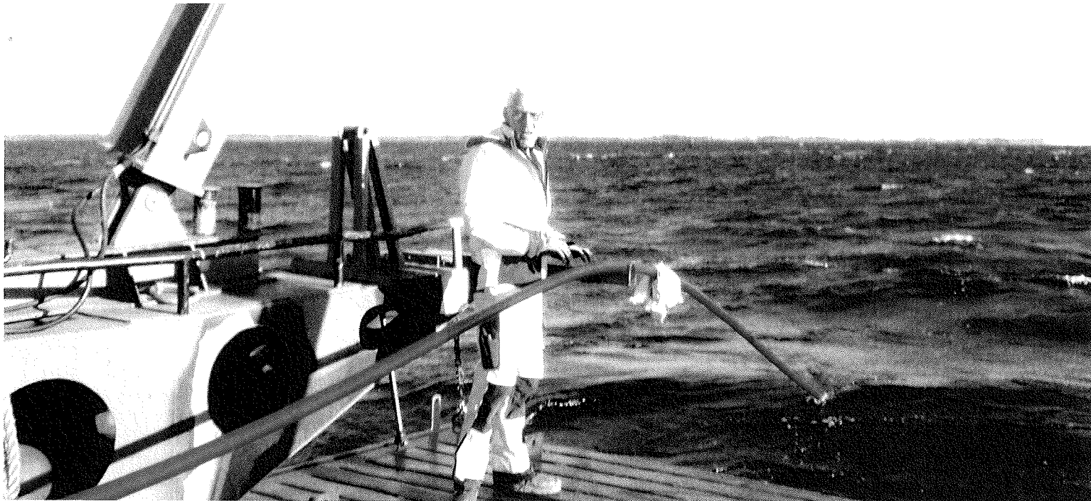
Elektriker Knud Elnegaard ved udlægning af søkabel
