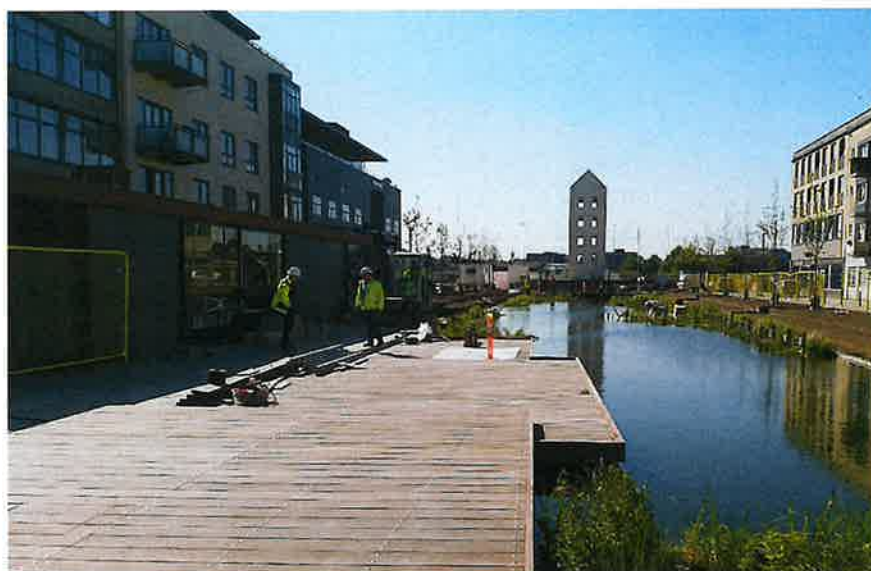
Brdr. Andersen udførte i 2021 projektet Regnvandsbassin Østervold i Randers.
