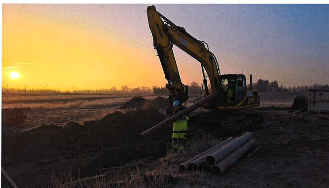
Byggemodning – Frostklar morgen - Munkdrup
