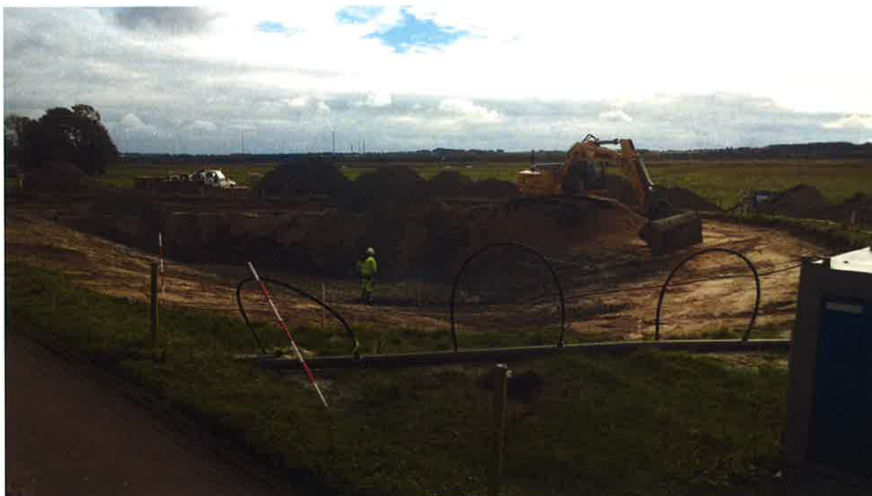
Separatkloakering og regnvandsbassin i Tjærby.
