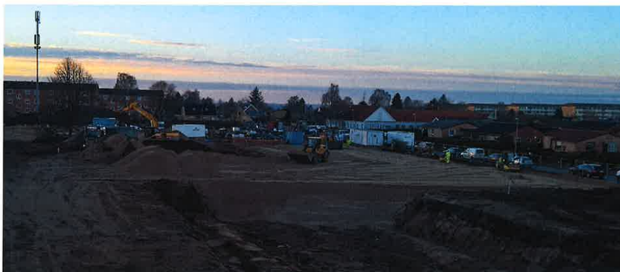
Jord-, kloak- og belægningsarbejder – Fremtidens Plejehjem i Randers.
