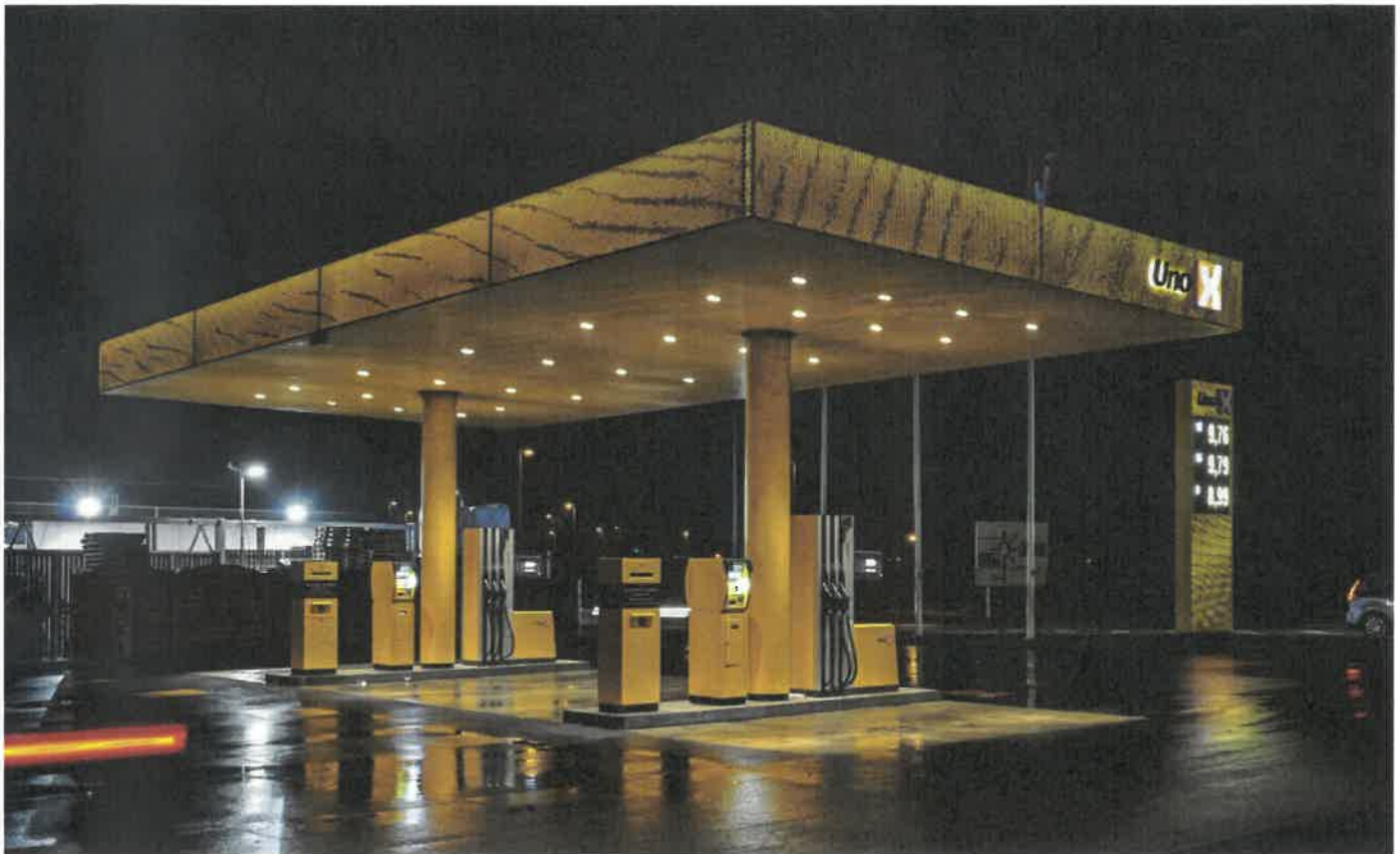
Lyskilden der gir' meget igen - I løbet af regnskabsåret har vi leveret akryl og LED-belysning til Uno-X tankstationer, der sikrer en driftssikker belysning på tankstationerne mange år fremad. Kanten af den flade tagkonstruktion lyser igennem akryl på bedste vis. Det samme gælder logo og pylon.
