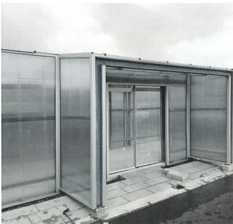
Projekt der tåler vindhastighed på 55 m/s - Store byggeprojekter har påvirket året positivt. Vagar Lufthavn på Færøerne, indvier om kort tid et projekt med tre lange gangtunneler bygget af facadepanel-vægge, termotag og med vinduer i massive PC plader. Flypassagerer kan snart gå tørskoet fra P-pladserne til ankomst- og afgangshallen og i læ for de hårde storme fra Nordatlanten.
