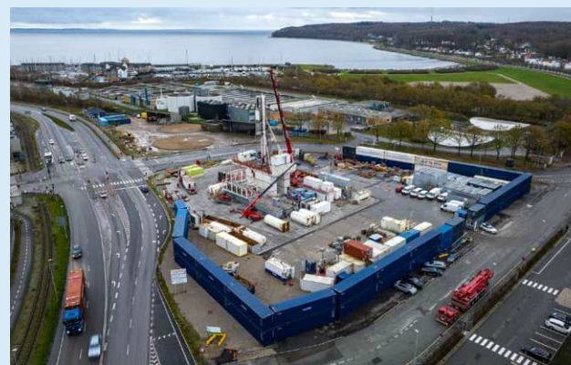
Borearbejdet i gang på Sumatravej - 2023
