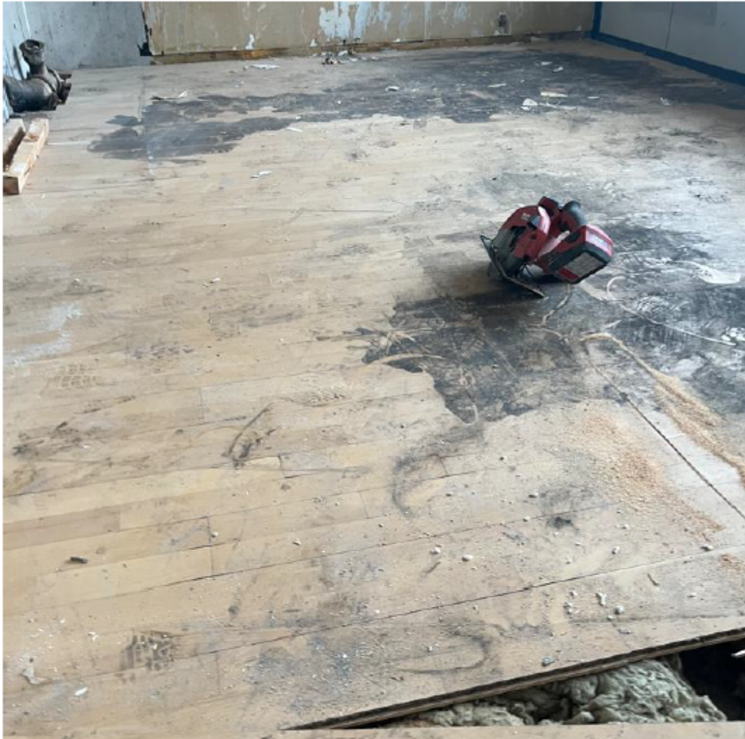
Gulvene nedrives selektivt så genbrug er muligt
