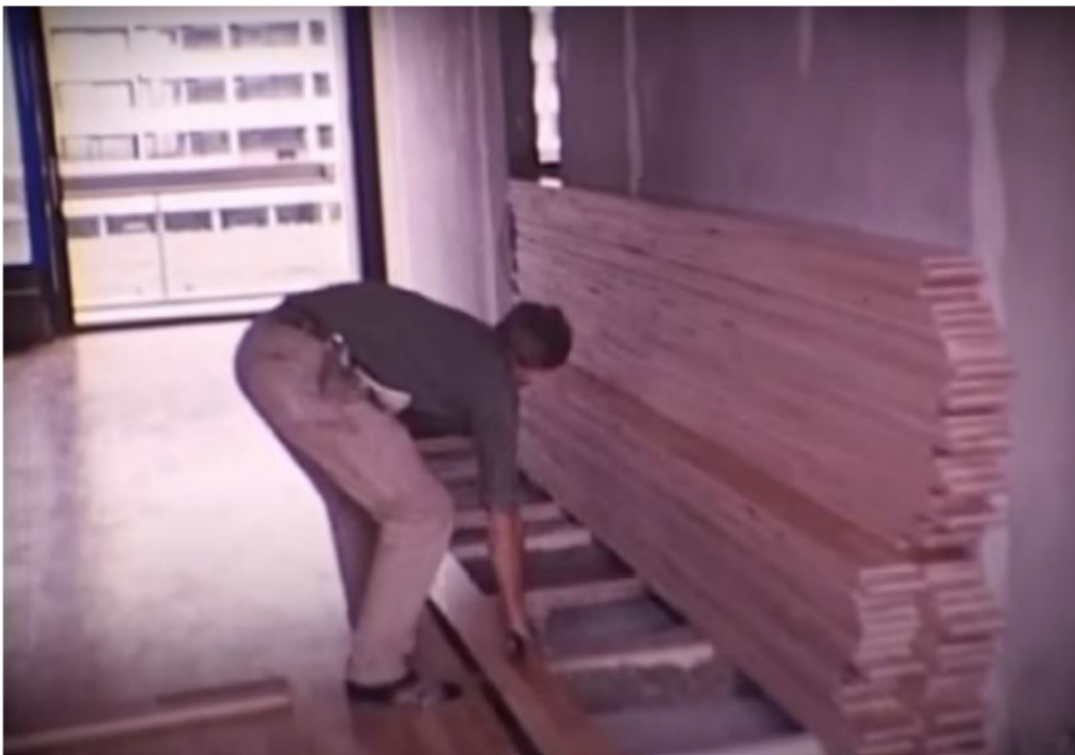
Foto fra opførelse af Gellerupparken i starten af 1970'erne. Det er gulvene fra foto der nu sættes til salg
