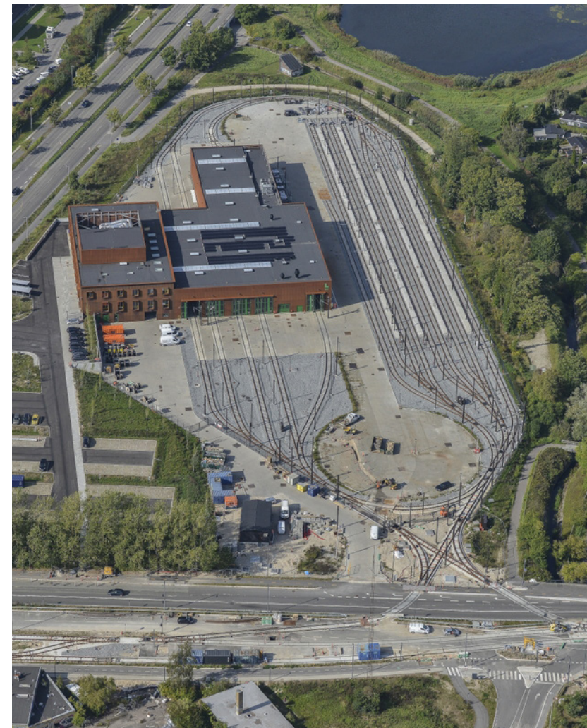
400 m 2 solceller på taget af kontrol- og vedligeholdelsescentret leverer strøm til drift af bygningerne.
