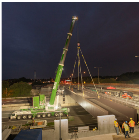
Broløft hvor Buddingevej krydser Motorring 3.
