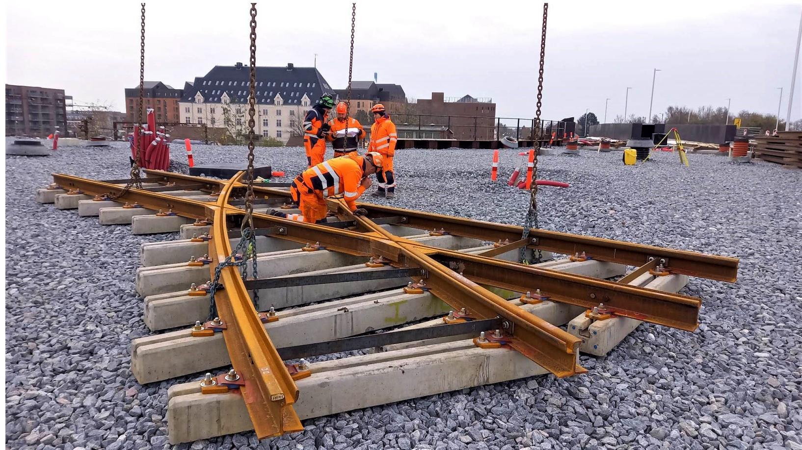
Sporskifter lægges på plads på rampen, der skal føre letbanen til og fra Glostrup Station.
