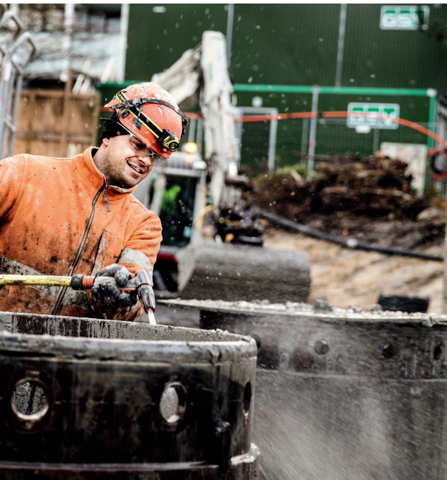
På Lyngby Station fyldte byggeriet af to nye tunneller under sporene meget i 2019. Foto: Ditte Valente
