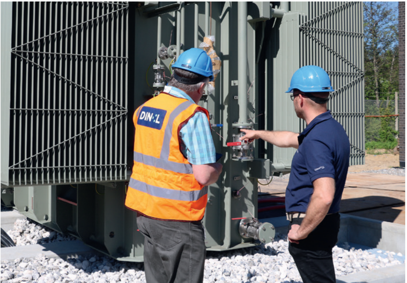
I 2018 renoverede vi 60/10 kV stationen på Risdalsvej i Viby, blandt andet med to nye specialbyggede transformere.
