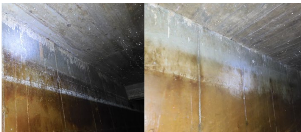
Vægge i tanken før rengøring
