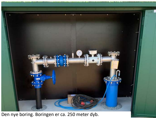
En vandboring henter vand op fra et grundvandsmagasin.
