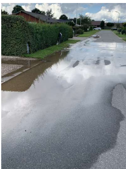
Overfladevand der kommer fra et vandbrud på en vandledning
