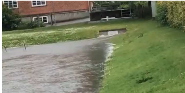
Overløb ved skybrud, Brørupskolen
