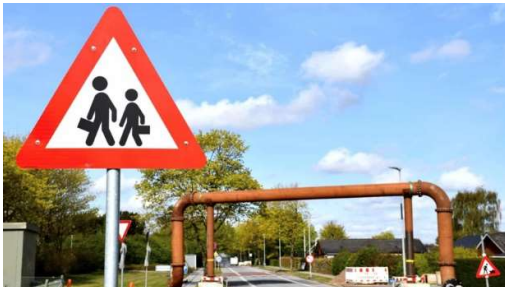
Overpumpningsledning på byggervej
