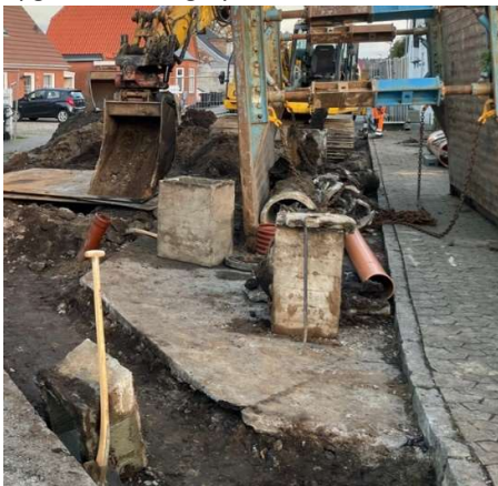
Sætning af ny brønd, Grunnetsgade Vejen
