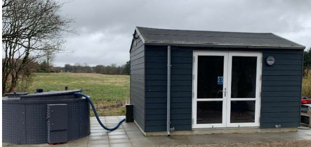
Pumpehuset ved Lindknud renselanlæg.
