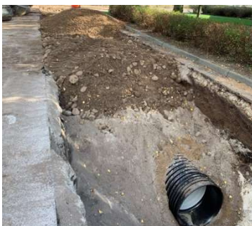
Gravearbejde i forbindelse med ny regnvandsledning
