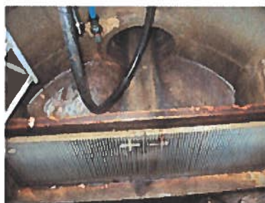
Overløbsbygværk, placeret på Fugle sangsalle, Vejen
