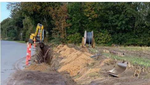
Hovborg-Holsted afskærende ledning - entreprenøren i gang med at grave ledningen ned i rabatten
