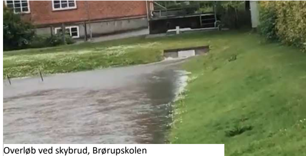
Overløb ved skybrud, Brørupskolen
