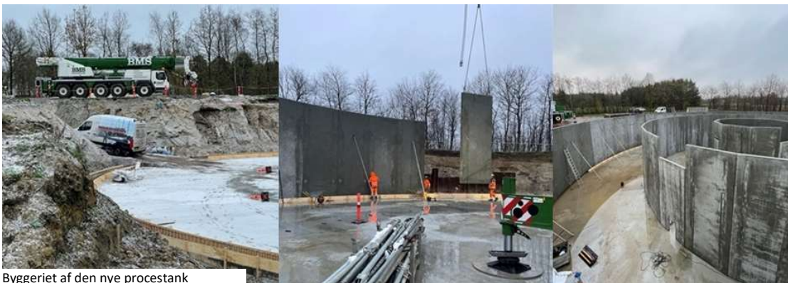
Byggeriet af den nye procestank
