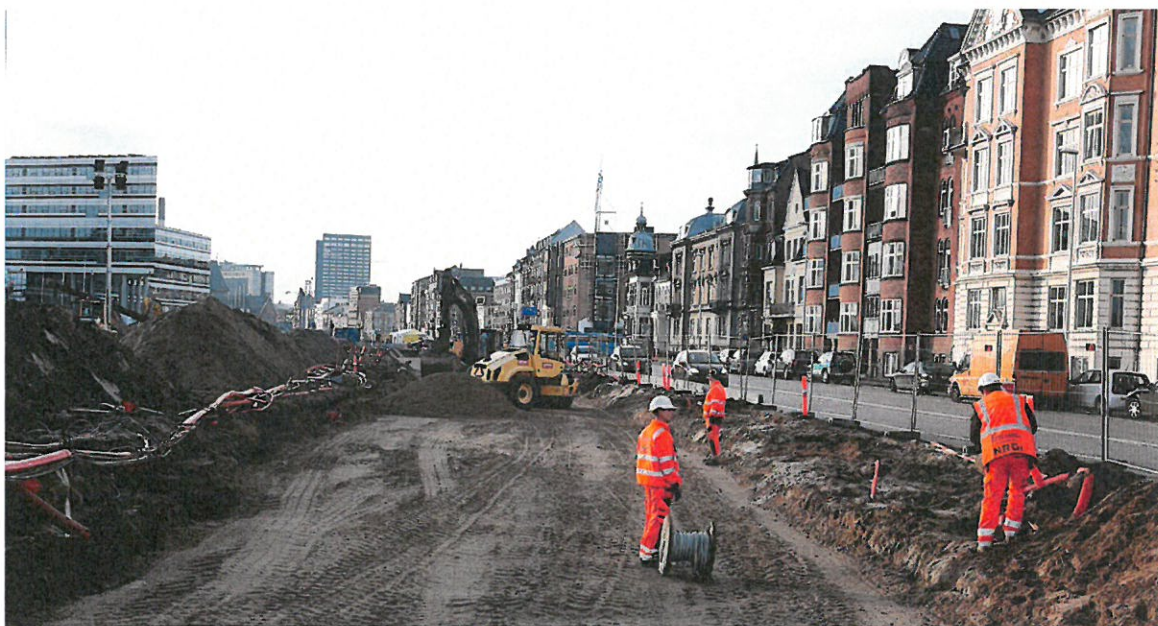
Med lukningen af nærbanen 26. august begyndte arbejdet med at etablere letbanespor langs havnefronten – her ved Kystvejen. Nærbanens bomme og hegn fjernes permanent, og dermed skabes der direkte forbindelse mellem by og hav. Chili Foto.
