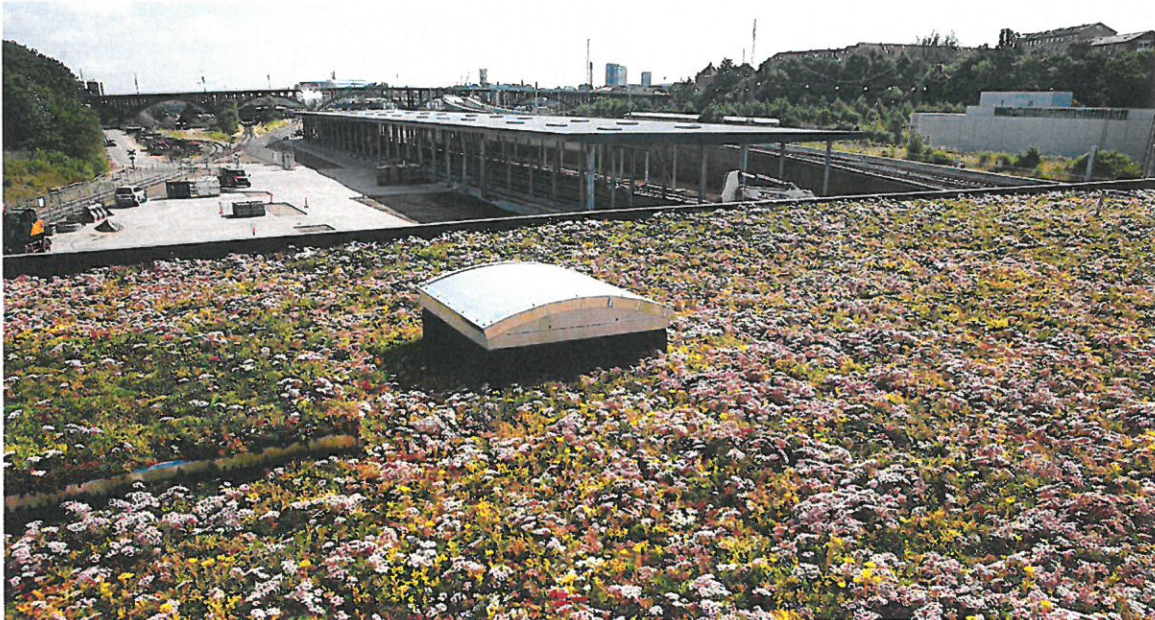
Planter på Trafik- og Service Centerets tag opsuger 12 ton CO2 om året og forsinket nedsvivning af regnvand. Chili Foto.
