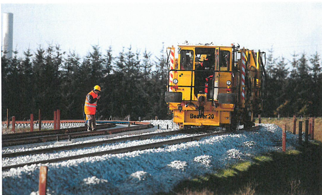
På strækningen mellem Lystrup og Skejby er der anlagt skinner i ballasteret dobbeltspor – her justeres skinnerne ved Elstedvej mellem Lystrup og Lisbjerg. Chili Foto.
