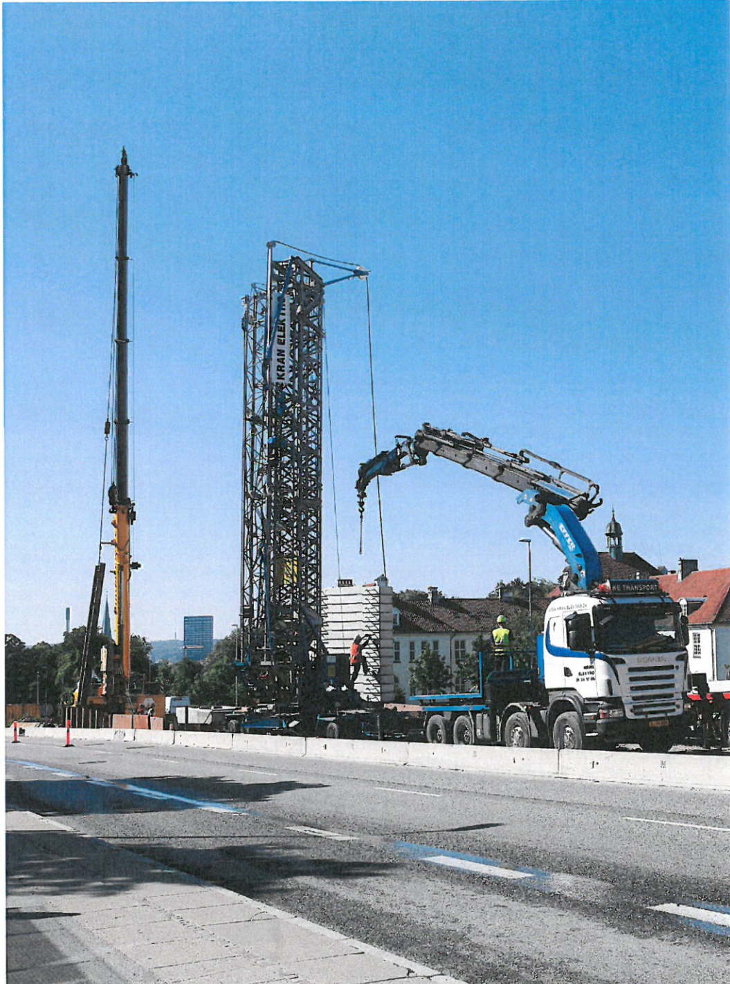
I løbet af sommeren 2015 blev der etableret en elevatorskakt i den eksisterende tunnel ved Wilhelm Meyers Allé mellem Universitetet og hospitalet på Nørrebrogade. Elevatoren fører op til letbanens standsningssted. Chilli Foto.
