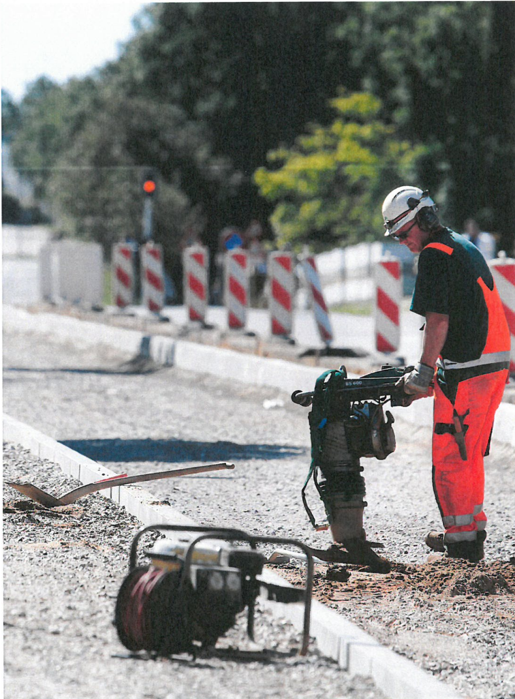
Henover sommeren begyndte arbejdet med at gøre plads til et dobbelt letbanespor på Olof Palmes Allé. Anlægsarbejdet medfører nye trafikale forhold i området, hvor al trafik fremover skal køre højre ind og høje ud på Olof Palmes Allé. Chili Foto.
