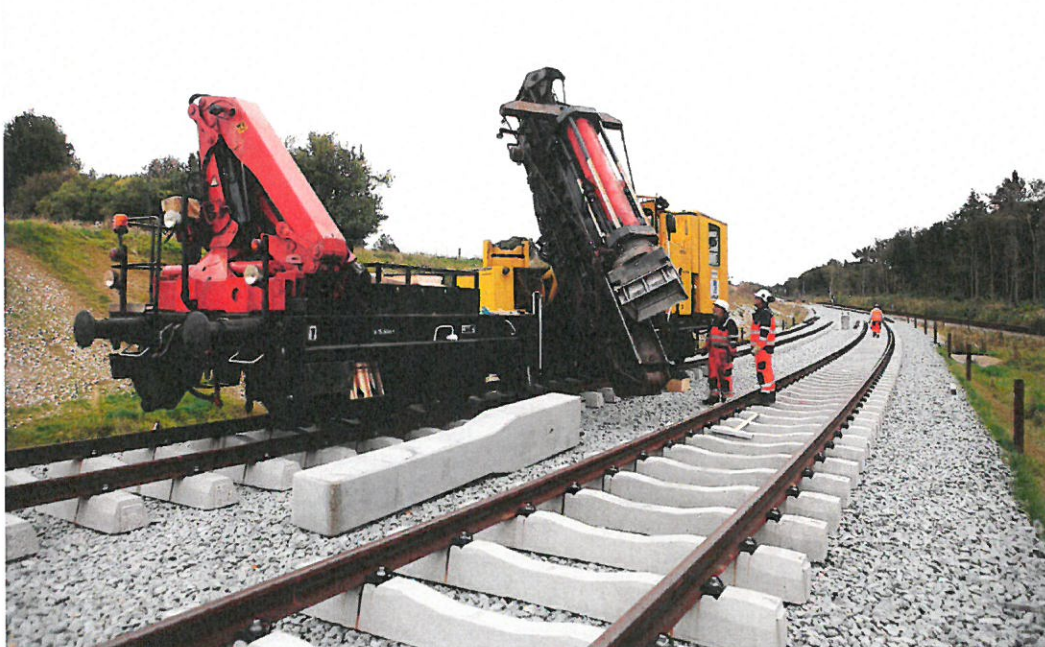
Sidst i 2015 begyndte arbejdet med at sætte fundamenter i jorden til kørestrømsmasterne – her på strækningen mellem Lystrup og Lisbjerg. I alt skal der placeres 3.000 master langs med Letbanen. Chili Foto.
