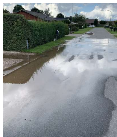
Overfladevand der kommer fra et vandbrud på en vandledning
