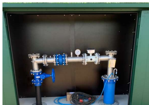
Den nye boring. Boringen er ca. 250 meter dyb.
