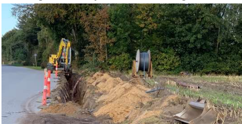
Hovborg-Holsted afskærende ledning - entreprenøren i gang med at grave ledningen ned i rabatten
