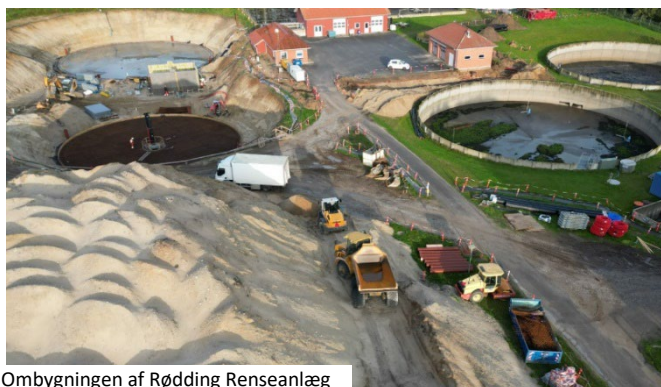
Ombygningen af Rødding Renseanlæg
