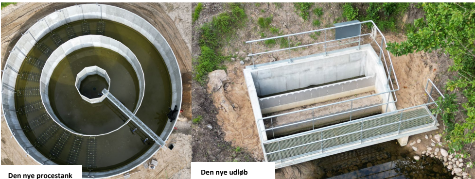
Den nye procestank
