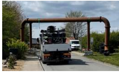
Overpumpningsledning på søparken
