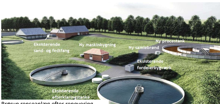
Brørup renseanlæg efter renovering
