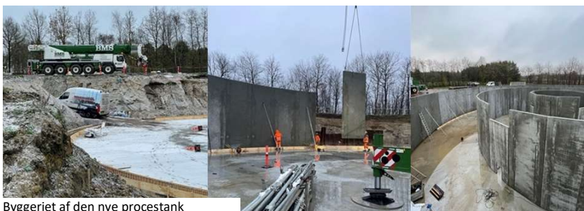
Byggeriet af den nye procestank
