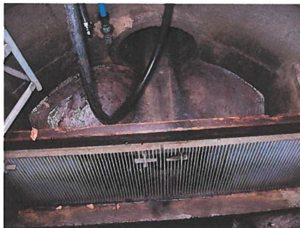
Overløbsbygværk placeret på Fuglesangsalle Vejen
