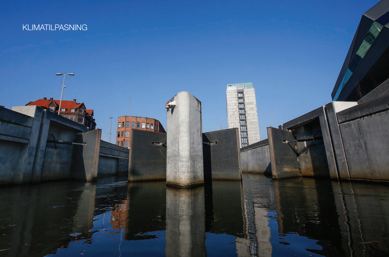
Sluseanlægget ved Dokk1.
