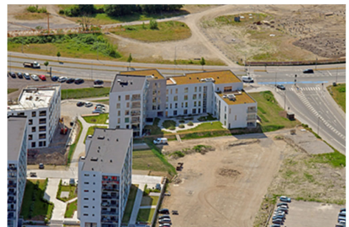
Landemærket med 56 lejligheder (med Mesanen i forgrunden.) Færdig og udlejet siden april 2018.
