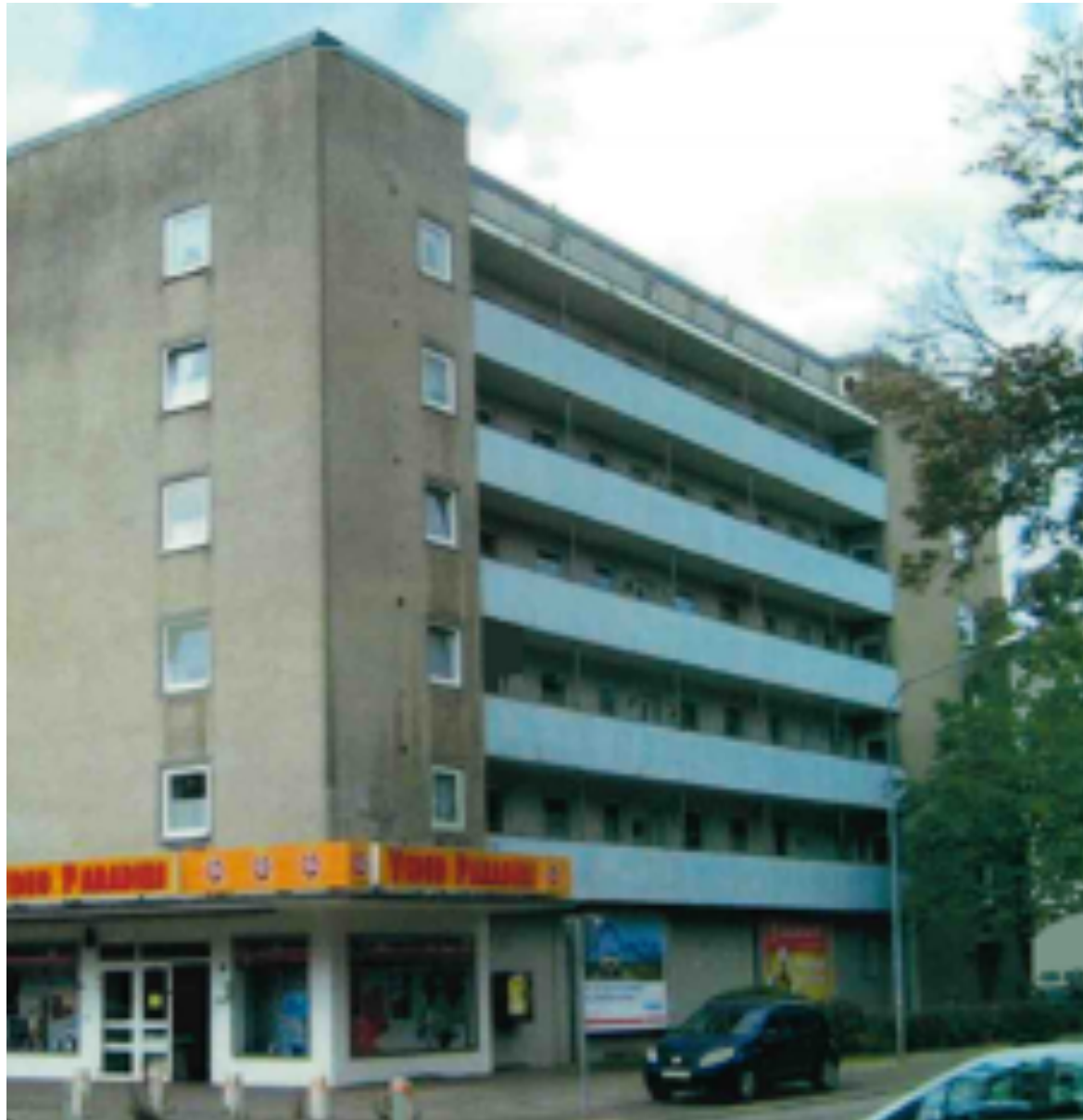
Marliring 94, Lübeck. Renovering af tag og facade og nyt opvarmningsanlæg. Svalegange renoveret og nye balkoner. Investering 4,4 mio. DKK
