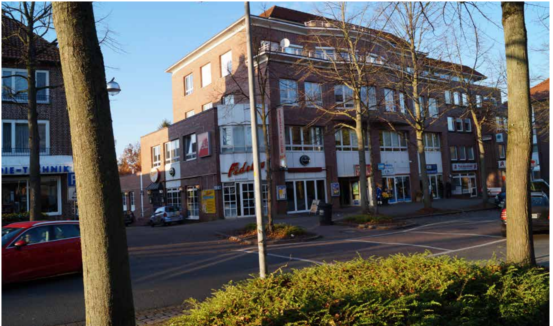
Bahnhofstrasse 48-50, Buxtehude, MC Property Fund Hamburg GmbH
