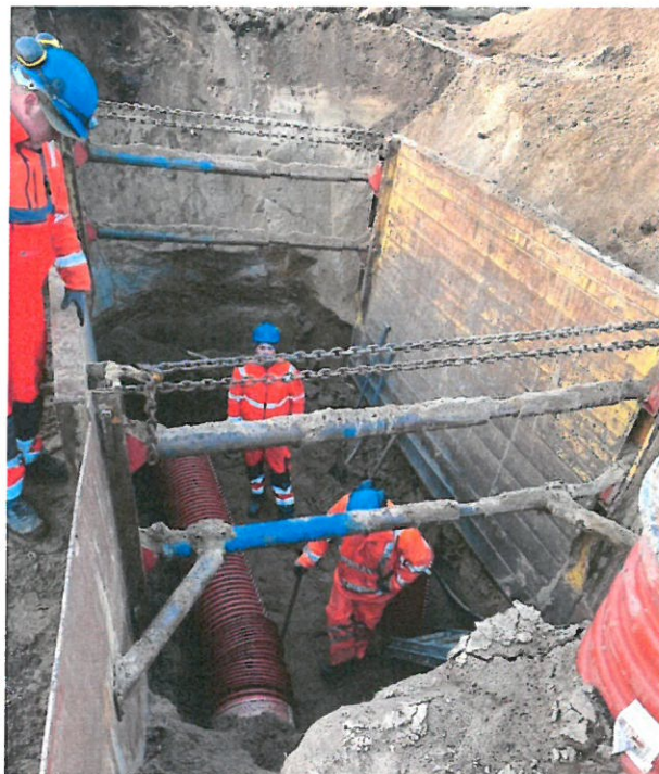
Viborgvej i Højslev. Spildevandsledning i stor dybde.
