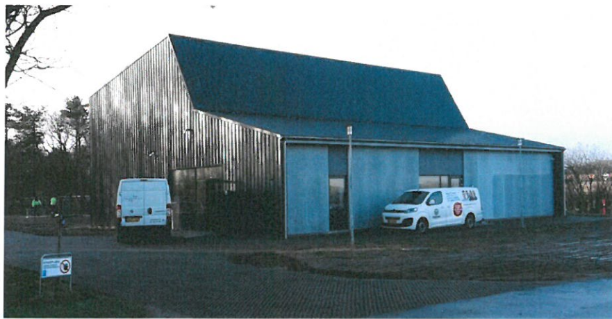
Det nye vandværk i Lem.
