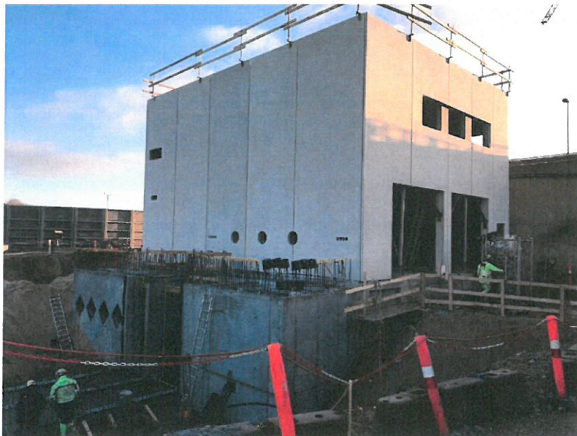
Indløbsbygning med pumpeump. Det nye udligningsbassin ses til venstre.
