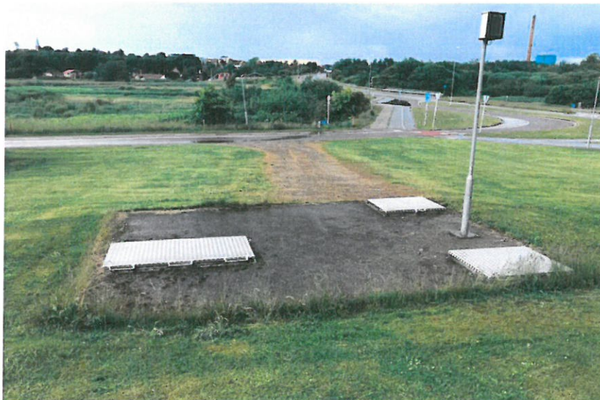
Overløbsbygværk ved Sdr. Boulevard i Skive. Bygværket er en indbygget "sikkerhedsventil" i kloaknettet som anvendes ved kraftig regn.
