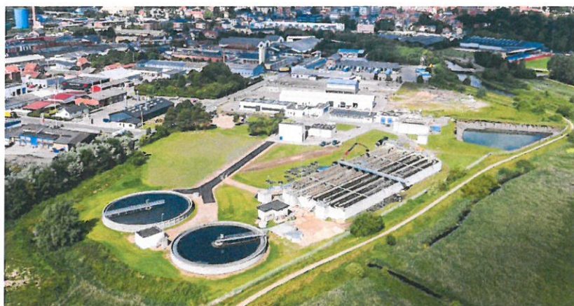
Skive renseanlæg efter at gamle tanke er fjernet og den nye efterklaringsstank er idriftsat. På billedet er den ene halvdel af processtanken tømt og under oprensning.
