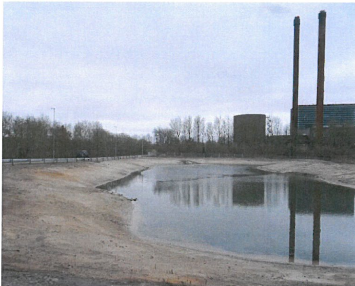
Nyt regnvandsbassin ved Thorsvej i Skive.
