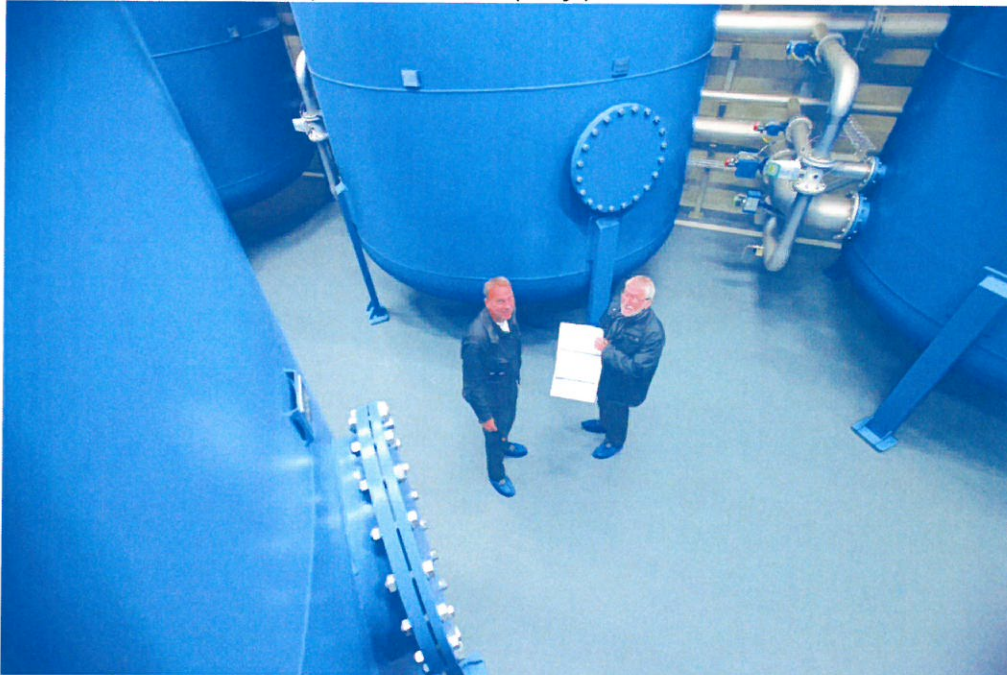
Filterbeholdere på Skive Vandværk.
