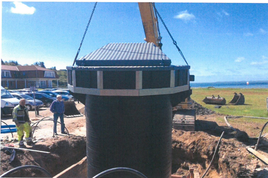
Ny pumpestation sættes på plads ved Hotel Pinenhus Renseanlæg
