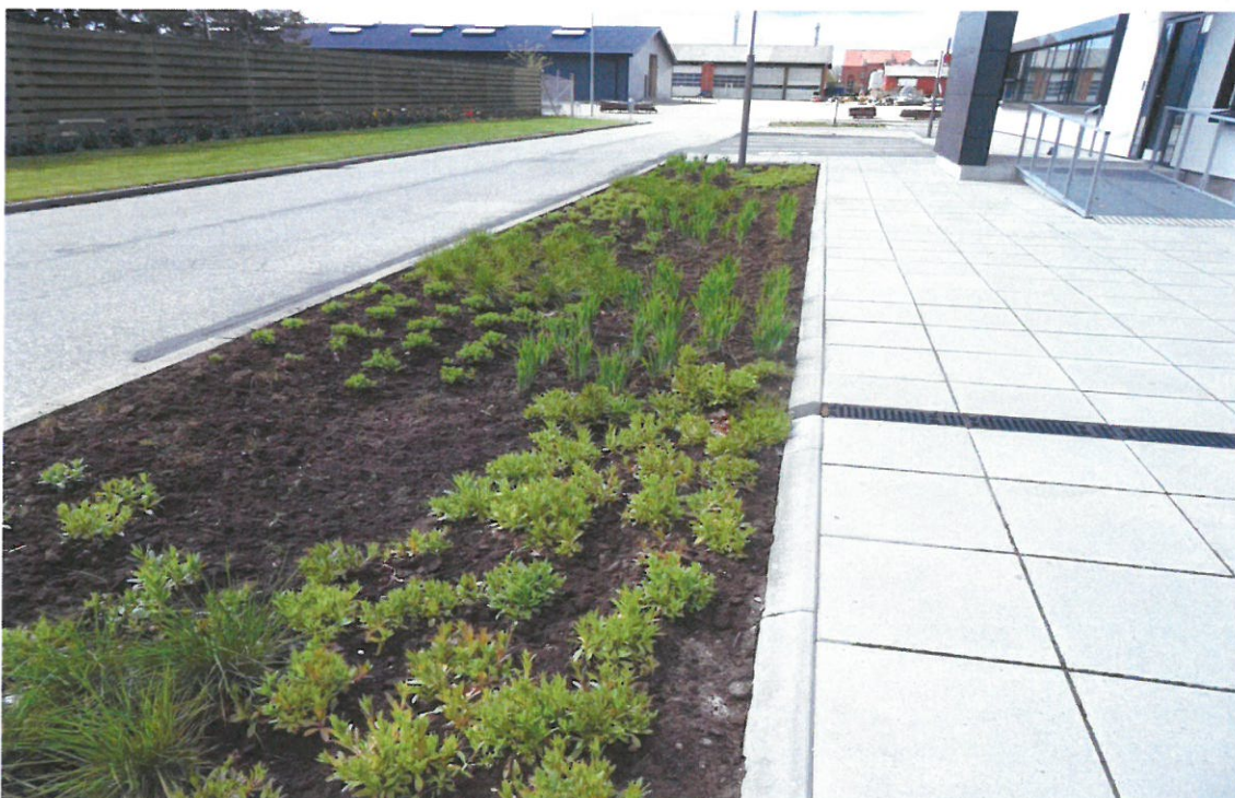
Regnvandsbed til nedsivning af tagvandet fra Skive Vands kontorbygning på Norgesvej i Skive. Grundejere opfordres til at nedsive regnvand, hvor det er muligt og hensigtsmæssigt.
