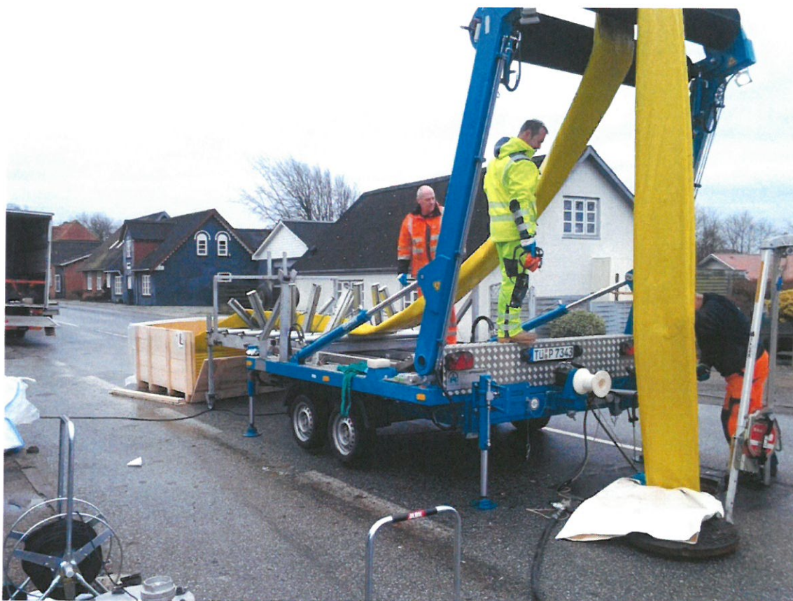
Glasfiberstrømpe trækkes ned i hovedkloak på Nørregade i Balling. Når strømpen er på plads, fyldes den med varmt vand, hvorefter strømpen hærdes op og bliver et nyt kloakrør inden i det gamle kloakrør.
