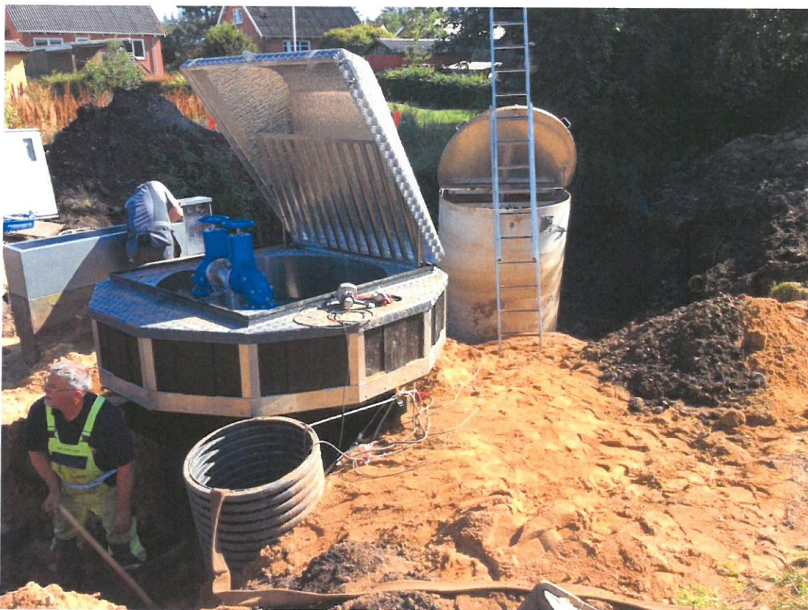
Etablering af en ny pumpestation til erstatning af den udtjente hvide pumpestation, som ses i baggrunden.
