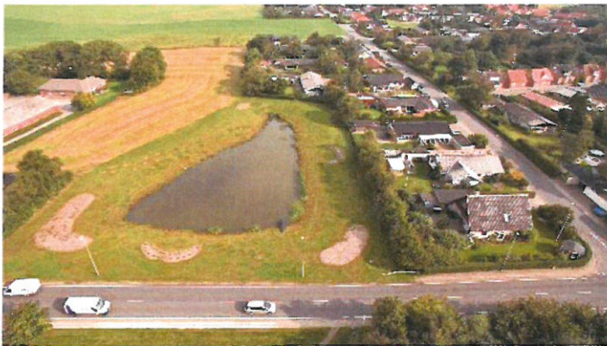
Nyt regnvandsbassin i Balling.
