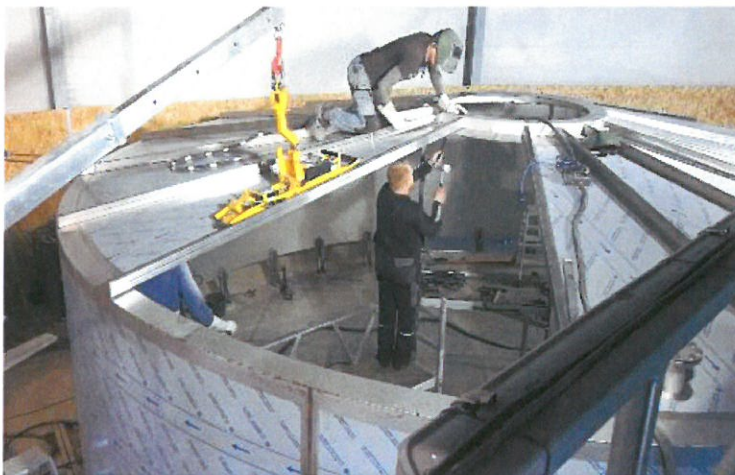
Den ene af de 2 rustfrie rentvandstanke under opsvejsning på Vihøj vandværk.
