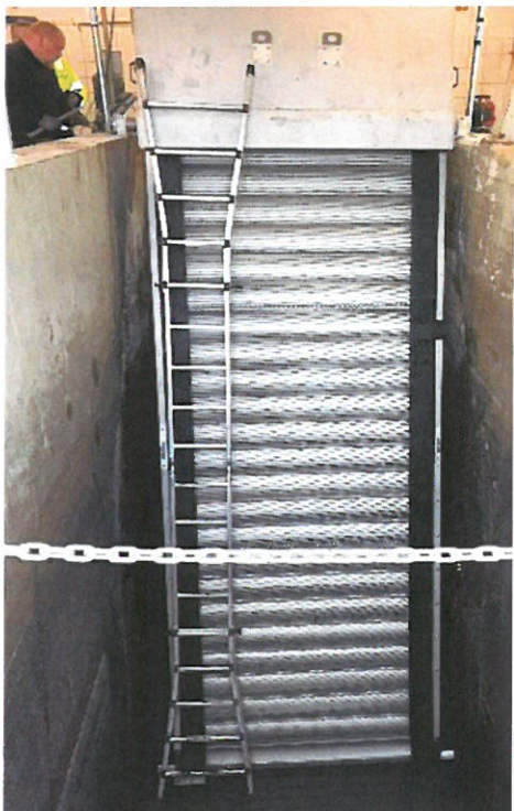
Montage af ny rist i indløbet til renseanlægget på Norgesvej.
