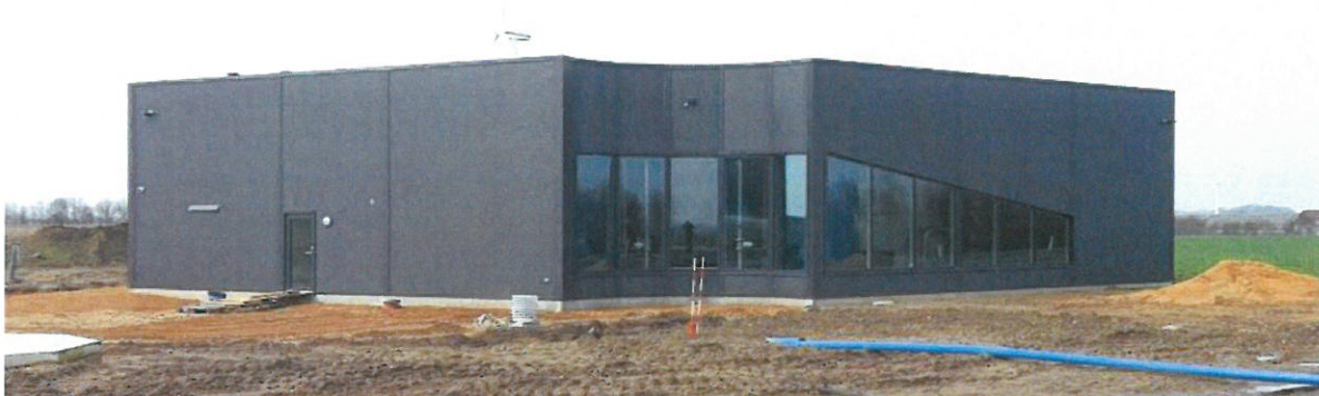
Det nye Vihøj vandværk er klar til indkøring og idriftsættelse.
