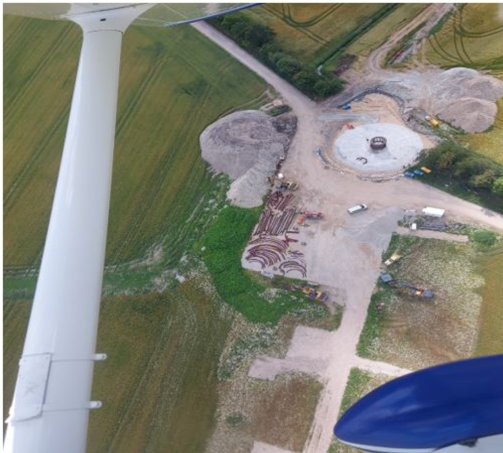
Vindpark Overgaard 1 A og 1 B, 26 x V126 (3,6 MW), under konstruktion Q2 2020-Q2 2021. Wind park Overgaard 1 A and 1 B, 26 x V126 (3.6 MW), under construction Q2 2020-Q2 2021.
