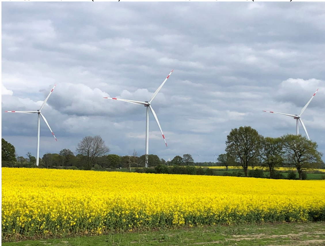
Vindpark Thorup-Sletten, Danmark. 18 x Siemens 4,3 MW. Under opførelse maj 2019-april 2020. Windpark Thorup-Sletten, Denmark. 18 x Siemens 4.3 MW. Under construction May 2019-April 2020.
