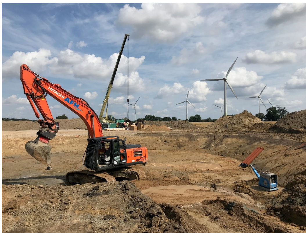
Vindpark Barkhorst, Tyskland. 2xV126 3,6 MW og 1xV117 3,45 MW. Under opførelse medio-ultimo 2019.
