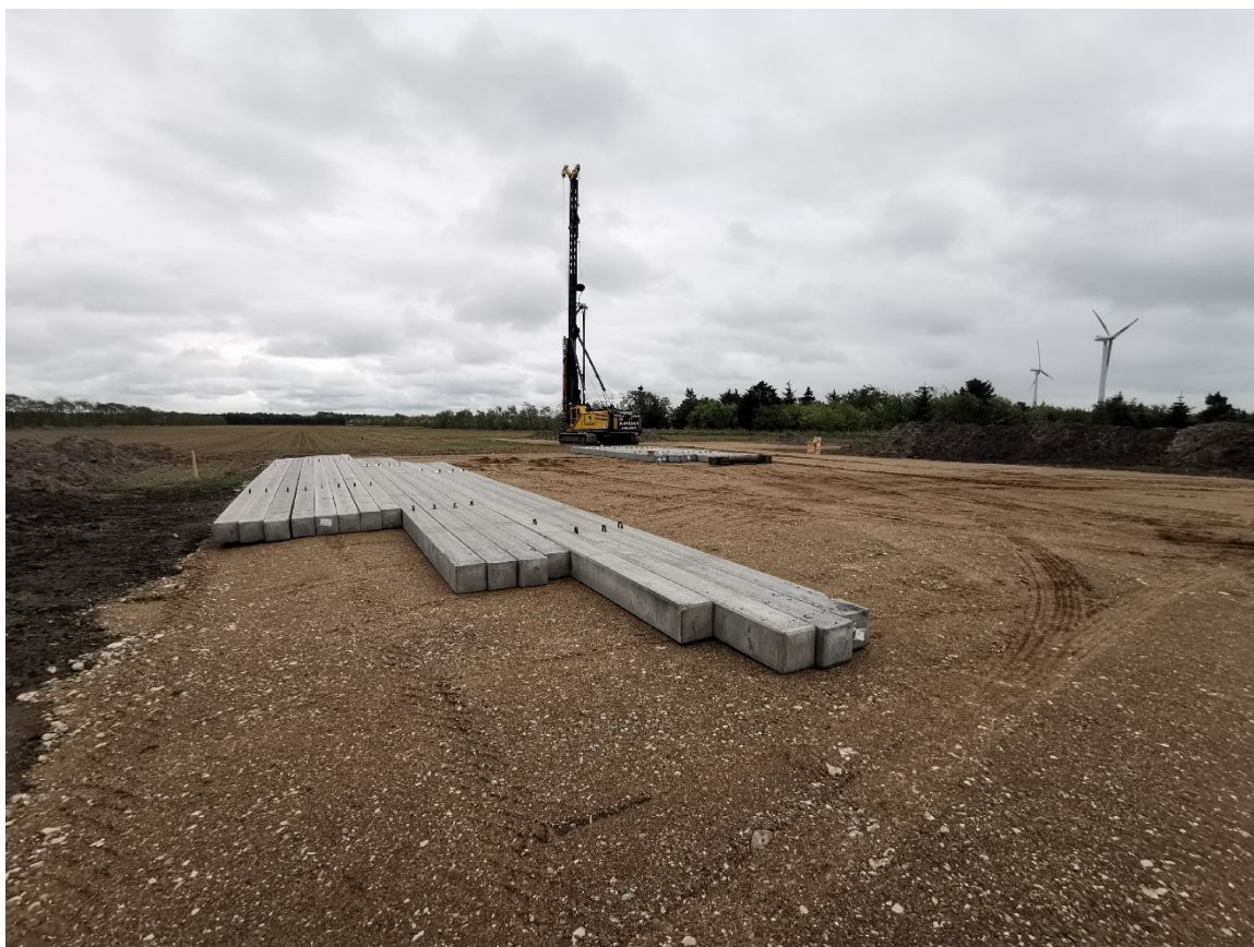
Vindpark Thorup-Sletten, Danmark. 18 x Siemens 4,3 MW. Under opførelse maj 2019-marts 2020. Windpark Thorup-Sletten, Denmark. 18 x Siemens 4.3 MW. Under construction May 2019-March 2020.
