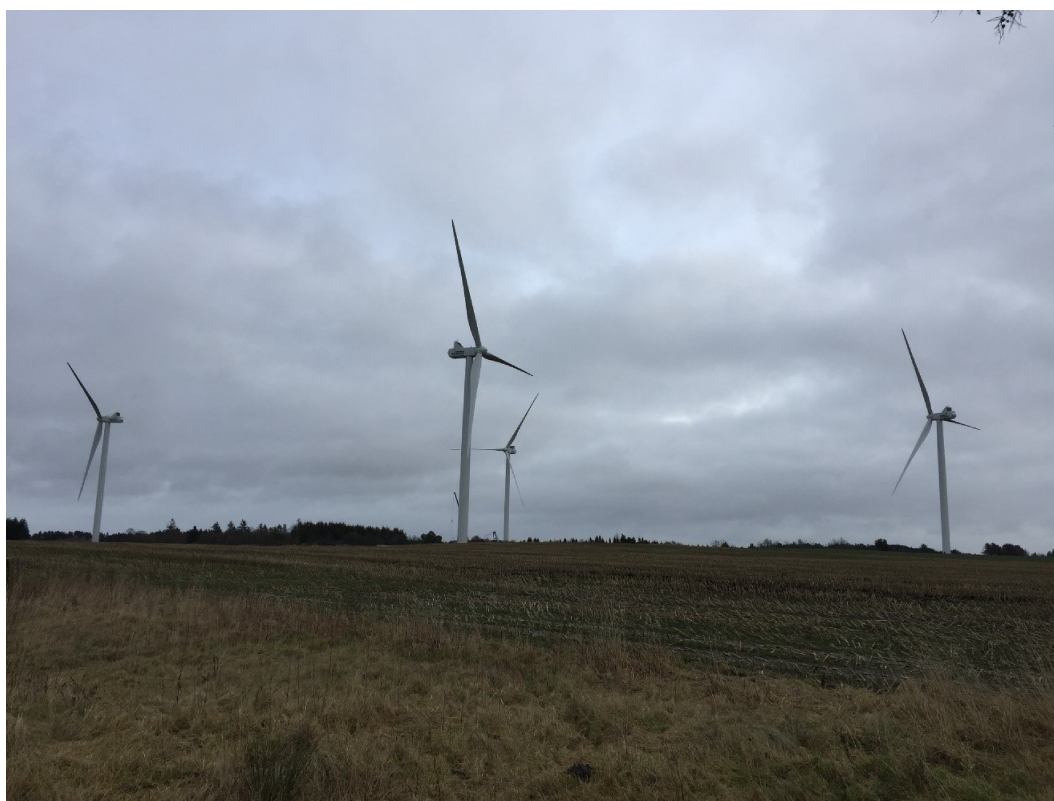
Vindpark Blæsbjerg, Danmark. 4xV112 3,45 MW. Idriftsat primo 2018. Wind park Blæsbjerg, Denmark. 4xV112 3.45 MW. Commissioned at the beginning of 2018.
