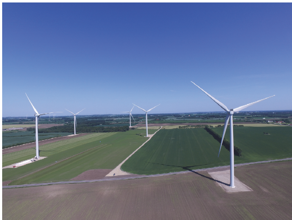
Vindpark Døstrup Vest, Danmark. 5xSWT113 3,2 MW. Idriftsat forår 2016. Wind park Døstrup Vest, Denmark. 5xSWT113 3.2 MW. Commissioned spring 2016.
