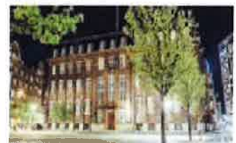
Casa Nordhavn - Nordhavn - 10 lejligheder Byggeri: JLF
