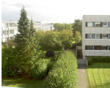
Houlkærvænget i Viborg
