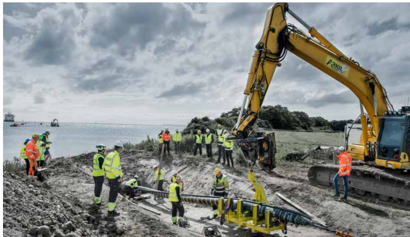
Energinet arbejder på at forstærke samhandelsforbindelser til Holland, England og Tyskland. Her ilandtrækkes søkablet til det EU-støttede Kriegers Flak-projekt, der skal forbinde tyske havvindmølleparker med en kommende dansk havvindmøllepark i Østersøen.
