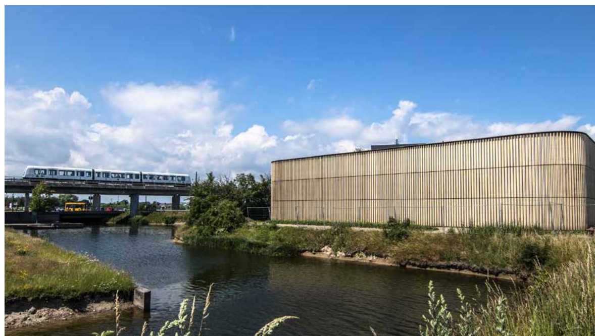
Fjernkølingscentral i Ørestaden.
