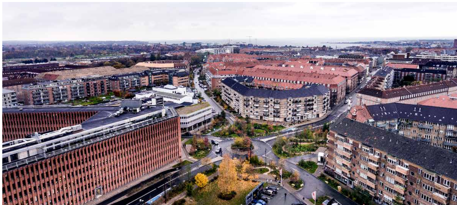
I starten af 2020 vandt området ved Skt. Kjelds Plads og Bryggervangen Arkitektforeningens pris Årets Arne. Her har HOFOR i samarbejde med Københavns Kommune været med til at skybrudssikre området.
