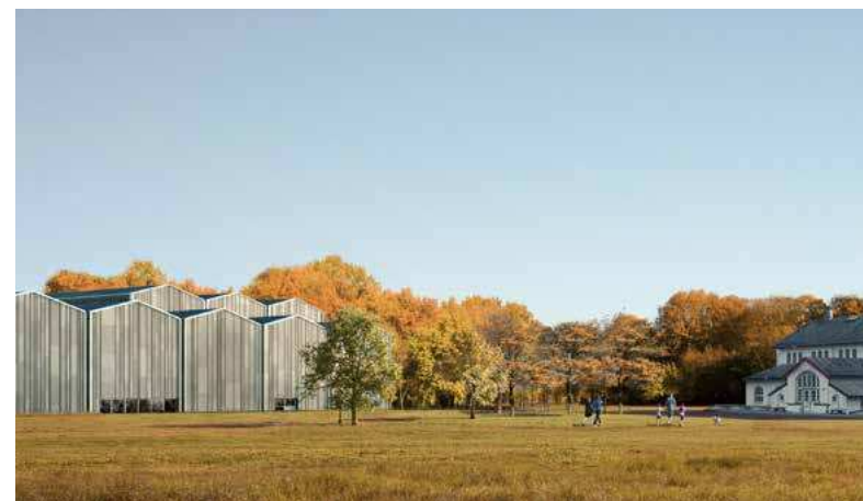
Vandværket ved Thorsbo, når ombygningen er færdiggjort. Til højre ses det gamle vandværk og til venstre det nye værk, hvor vinklerne i taget går igen fra den gamle bygning.
