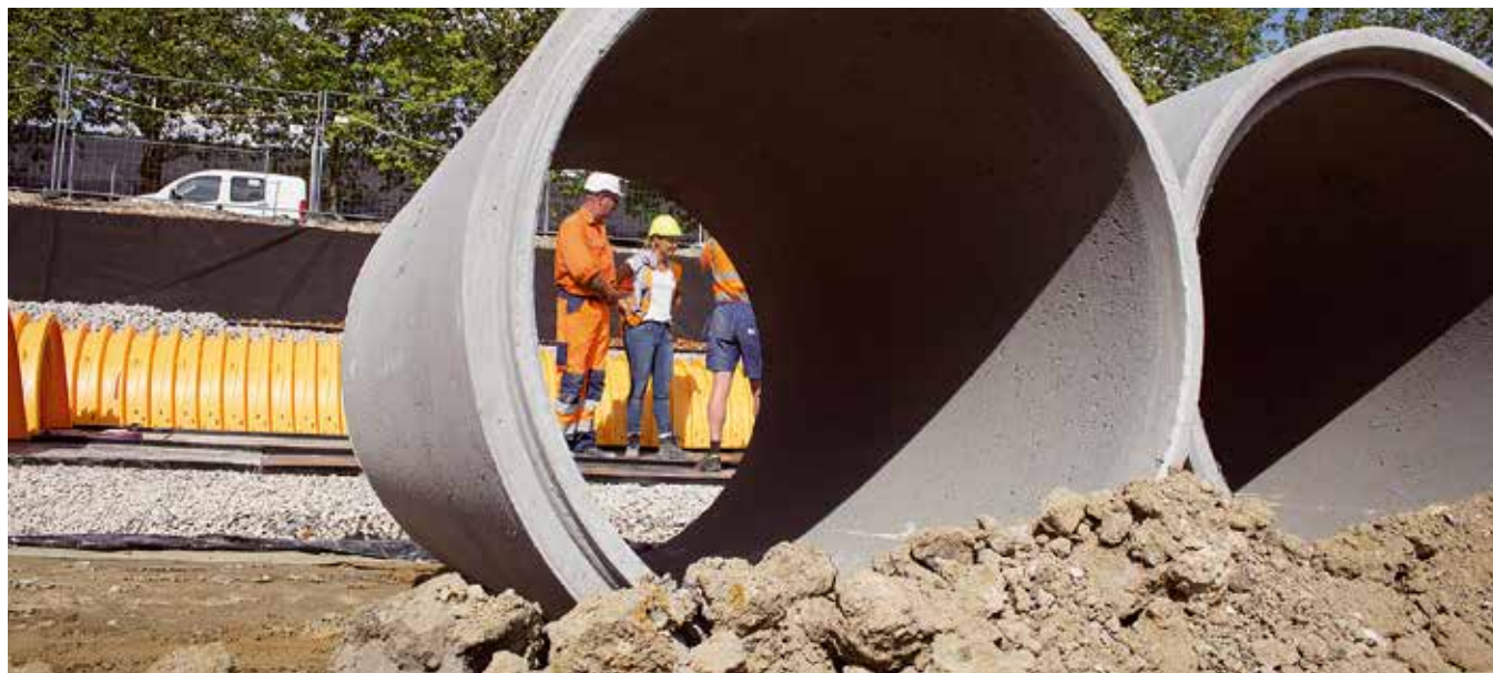
I 2019 blev parkeringsarealet på Horsedammen omdannet til et innovativt skybrudsbassin med tunnelfaskiner og permeabel asfalt.
