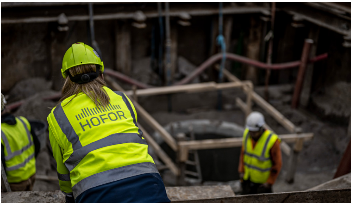
En HOFOR-medarbejder inspicerer byggepladsen.
