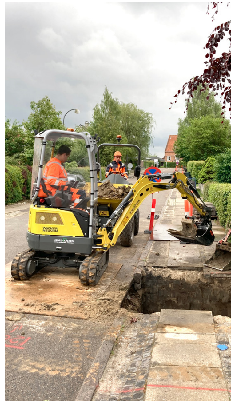
HOFOR udfører forsøg med eldrevne gravemaskiner i Herlev
