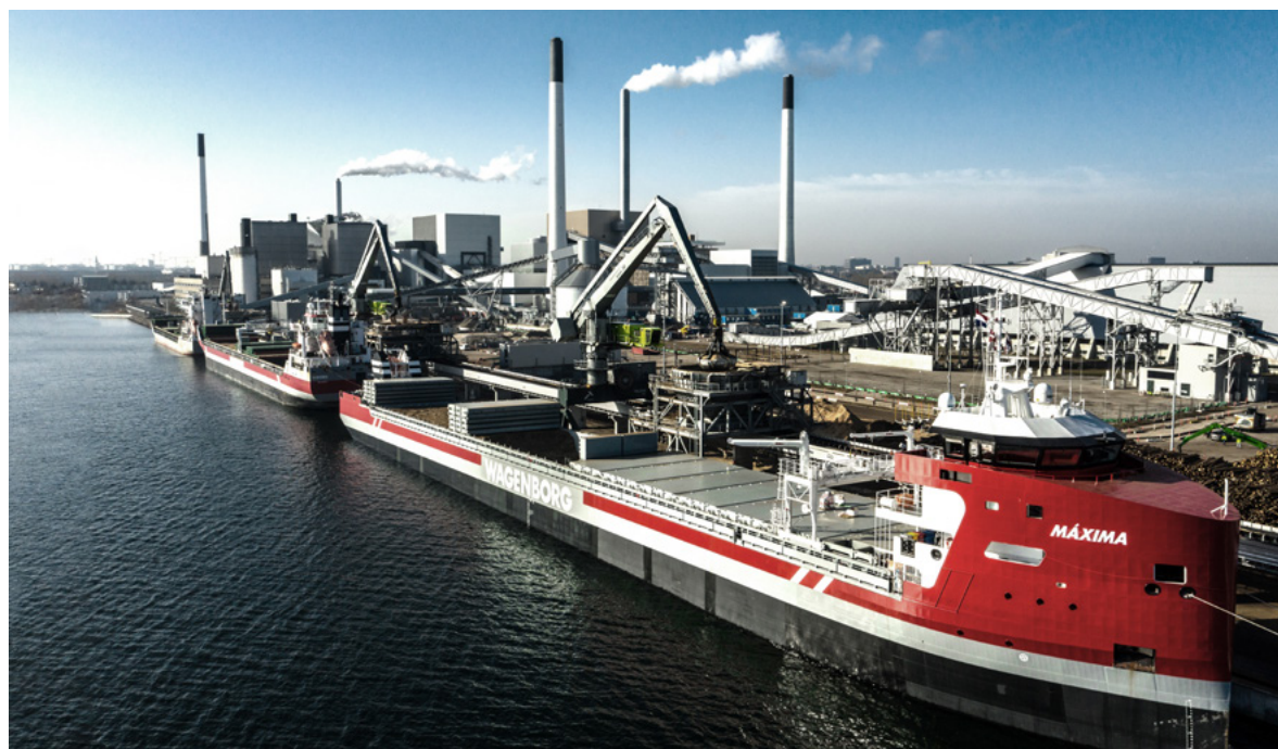
Amagerværket modtager bl.a. biomasse fra det særlige lavemissionsskib Maxima
