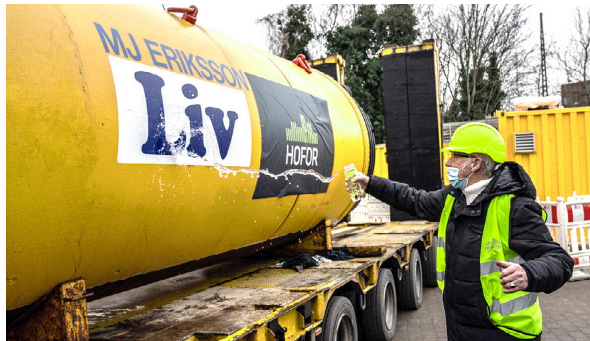
Tunnelboremaskinen Liv blev døbt ved sin ankomst på Tagensvej.
