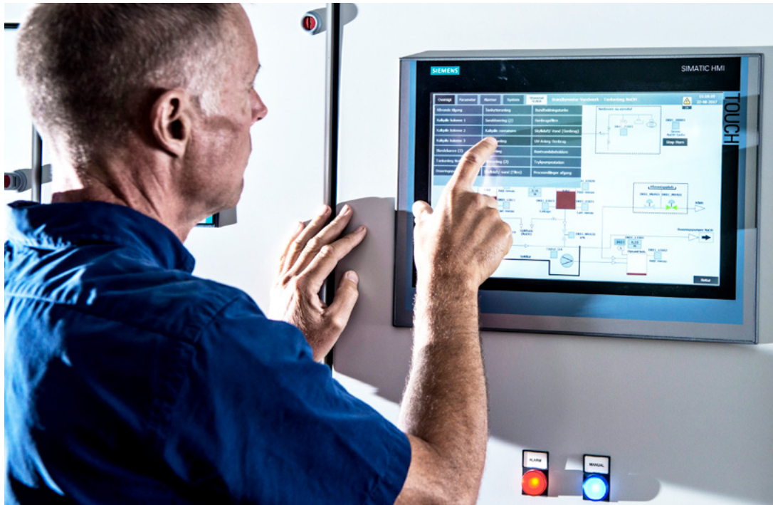
En HOFOR-medarbejder overvåger produktionen på Brøndbyvester Vandværk.
