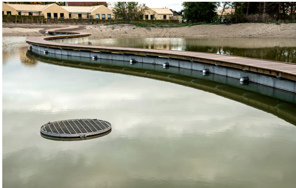
Klimatilpasningsanlægget på Strandengen i Vallensbæk stod færdigt i 2021.
