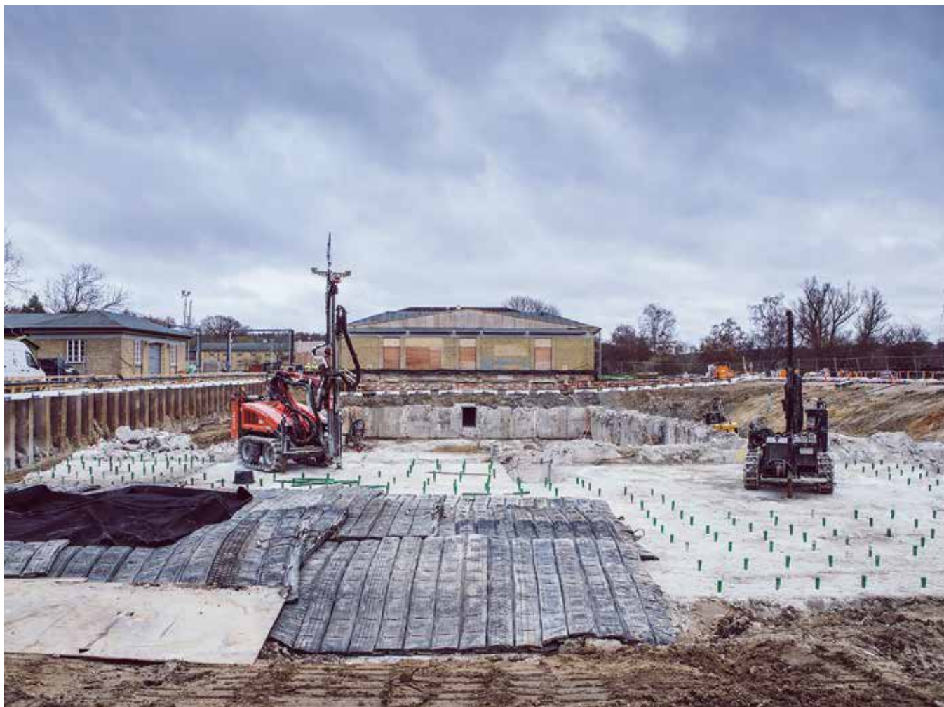
Der er gjort klar til den første sprængning af fundamentet på Vandværket ved Søndersø. Naboer blev inviteret med til at opleve sprængningen.
