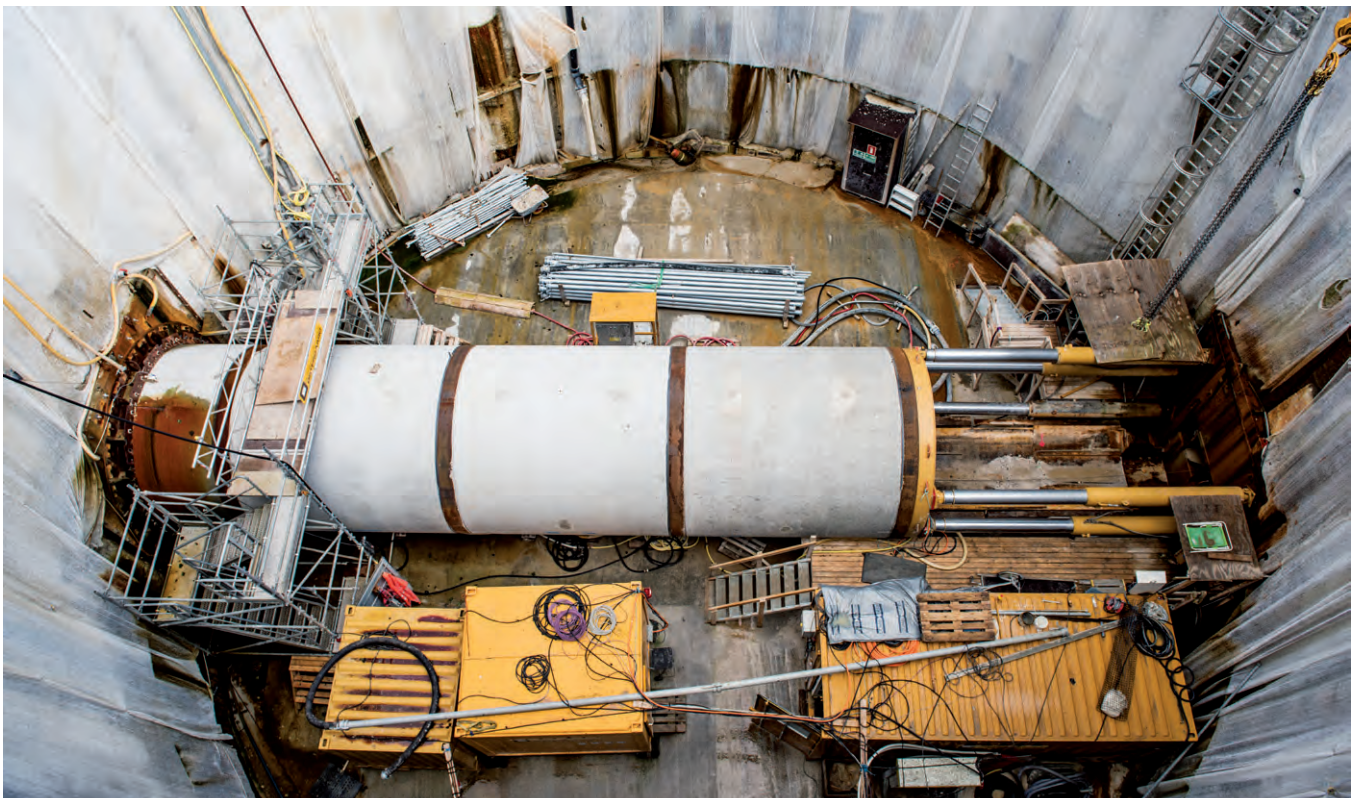
Ved Damhusåen skal to tunneler i fremtiden afhjælpe kloaksystemet og forhindre oversvømmelser. Her en af byggepladserne, hvor en tunnelboremaskine er sænket ned.
