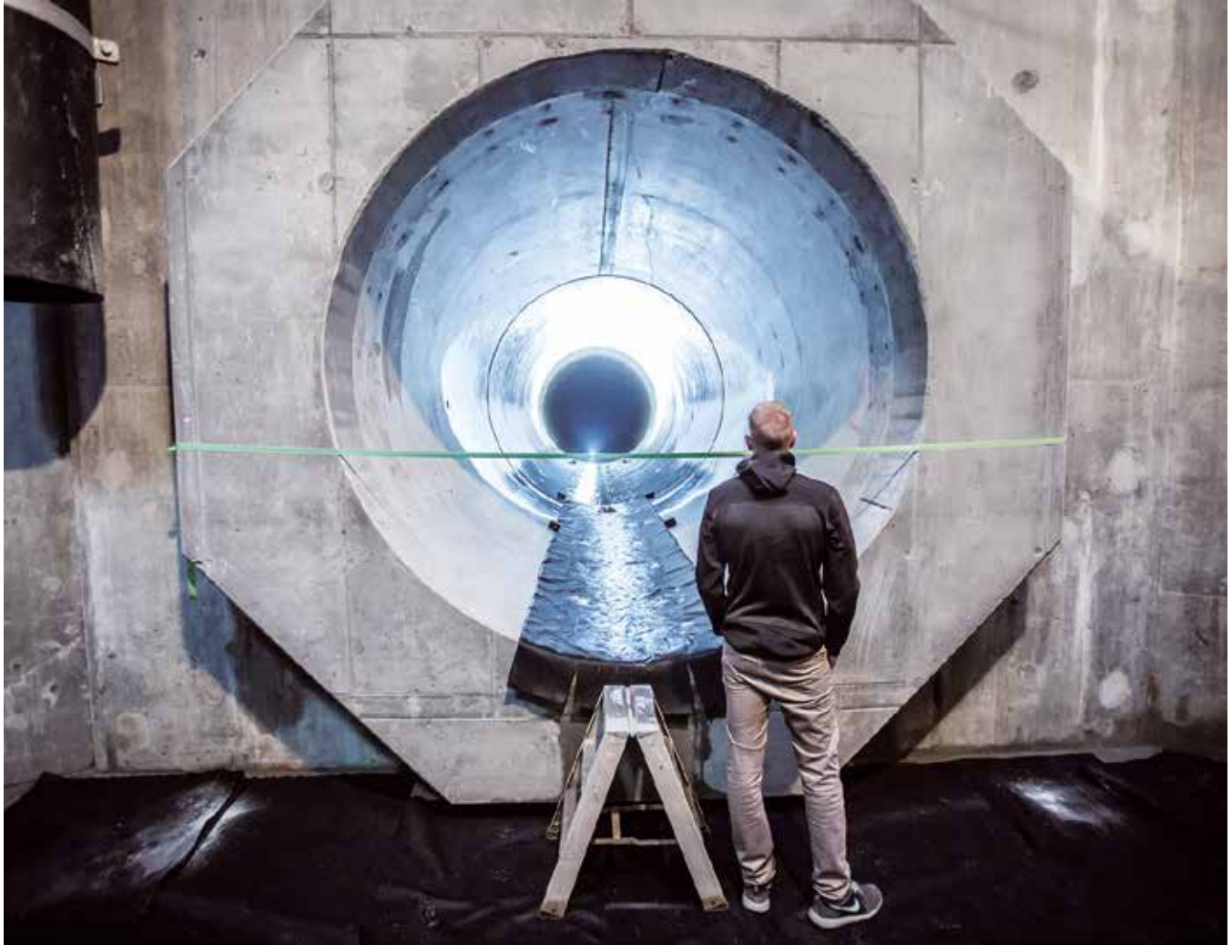
Regnvandstunnel på Østerbro blev indviet i august 2017.
