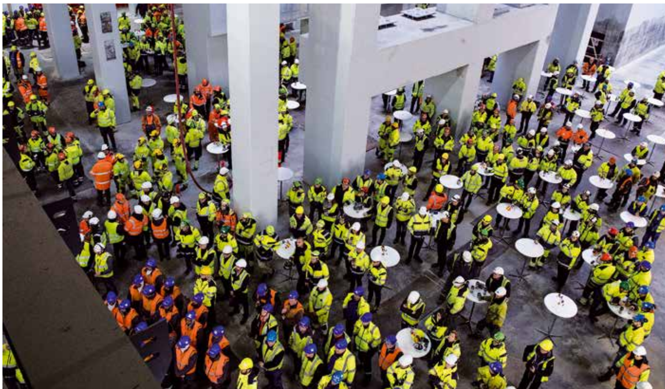
Der var helt gult af mennesker, da de omkring 1.000 arbejdere på BIO4-projektet var med til at fejre rejsegilde for den nye kraftværksblok.
