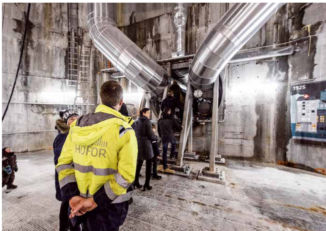
Naboer og andre nysgerrige fik mulighed for at krydse Københavns havn under vandet i den nye tunnel til fjernvarmerør.
