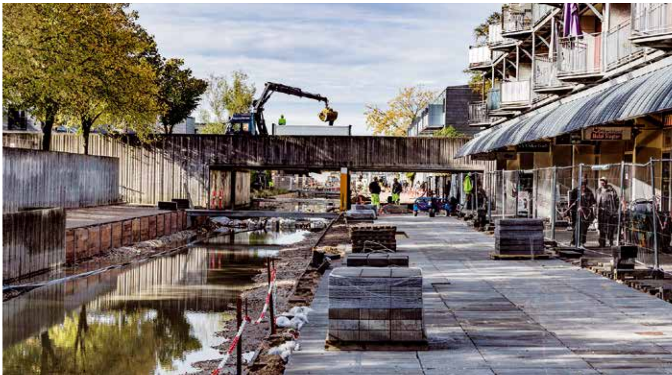
Gennem hele 2017 er der blevet arbejdet langs Kanalgaden, et klimasikringsprojekt i samarbejde mellem Albertslund Kommune og HOFOR.
