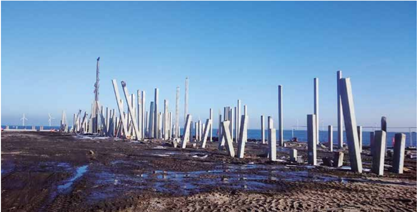
Flere end 6.500 pæle blev banket i jorden for at sikre fundamentet til den nye kraftværksblok på Amagerværket.
