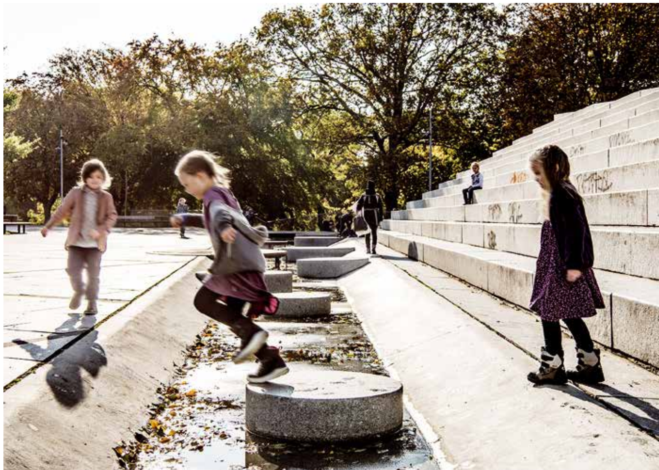
En plads udviklet til leg i tørvej og til at opsamle og forsinke tagvand, når det regner kraftigt.
