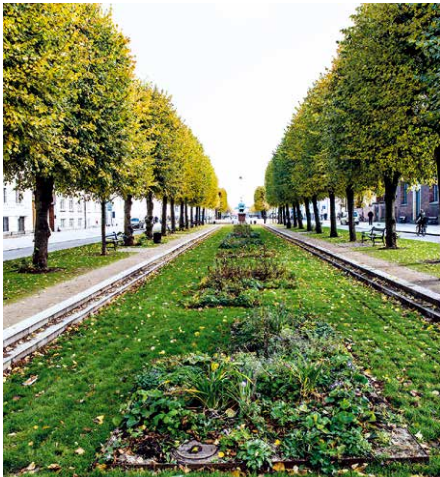
Skt. Annæ Plads i Indre By blev indviet i juni 2016. Pladsen er nu indrettet til at forsinke og opsamle regnvand, som tidligere oversvømmede gaderne i kvarteret.
