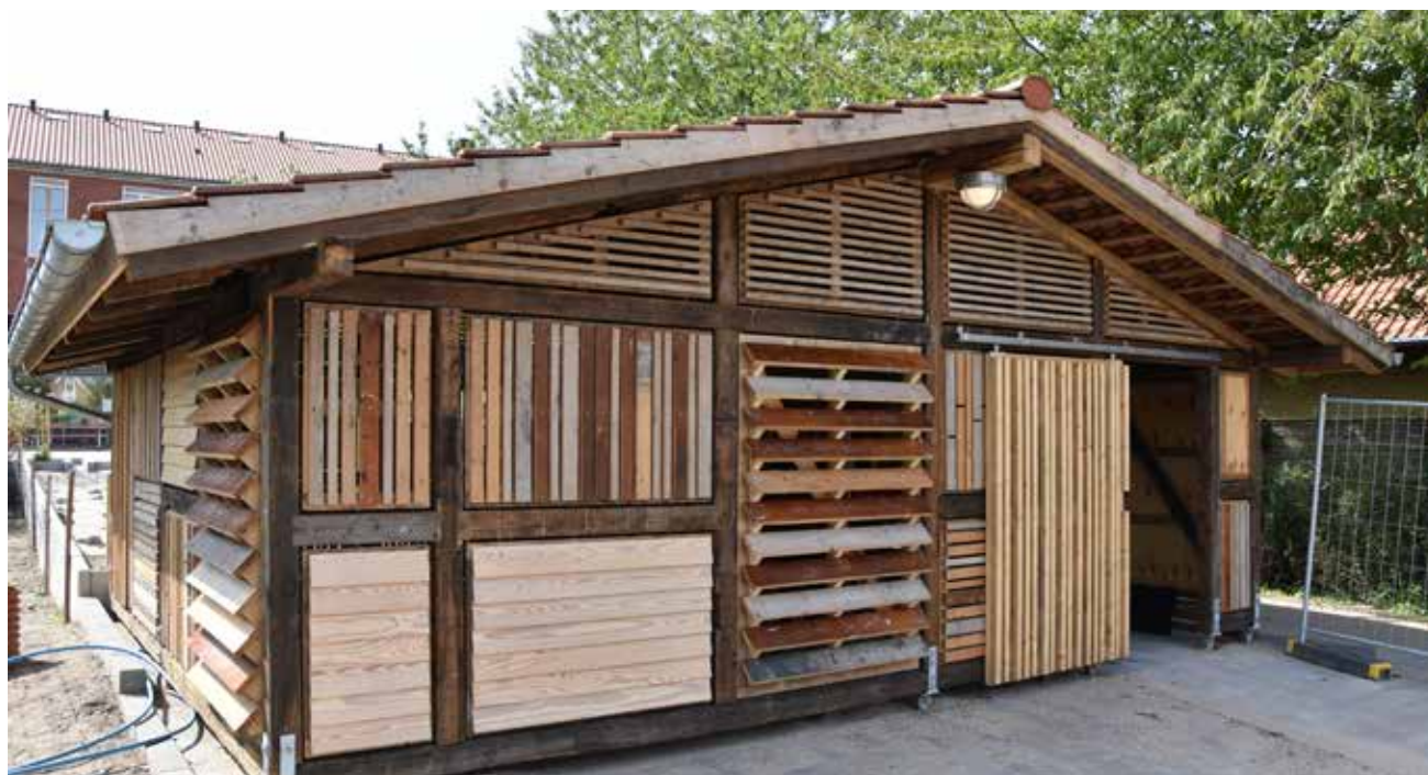
Tschernings har leveret materialer fra diverse nedrivningssager til projekt Reskur, der leverer bæredygtige skure udført næsten udelukkende i genbrugsmaterialer.
