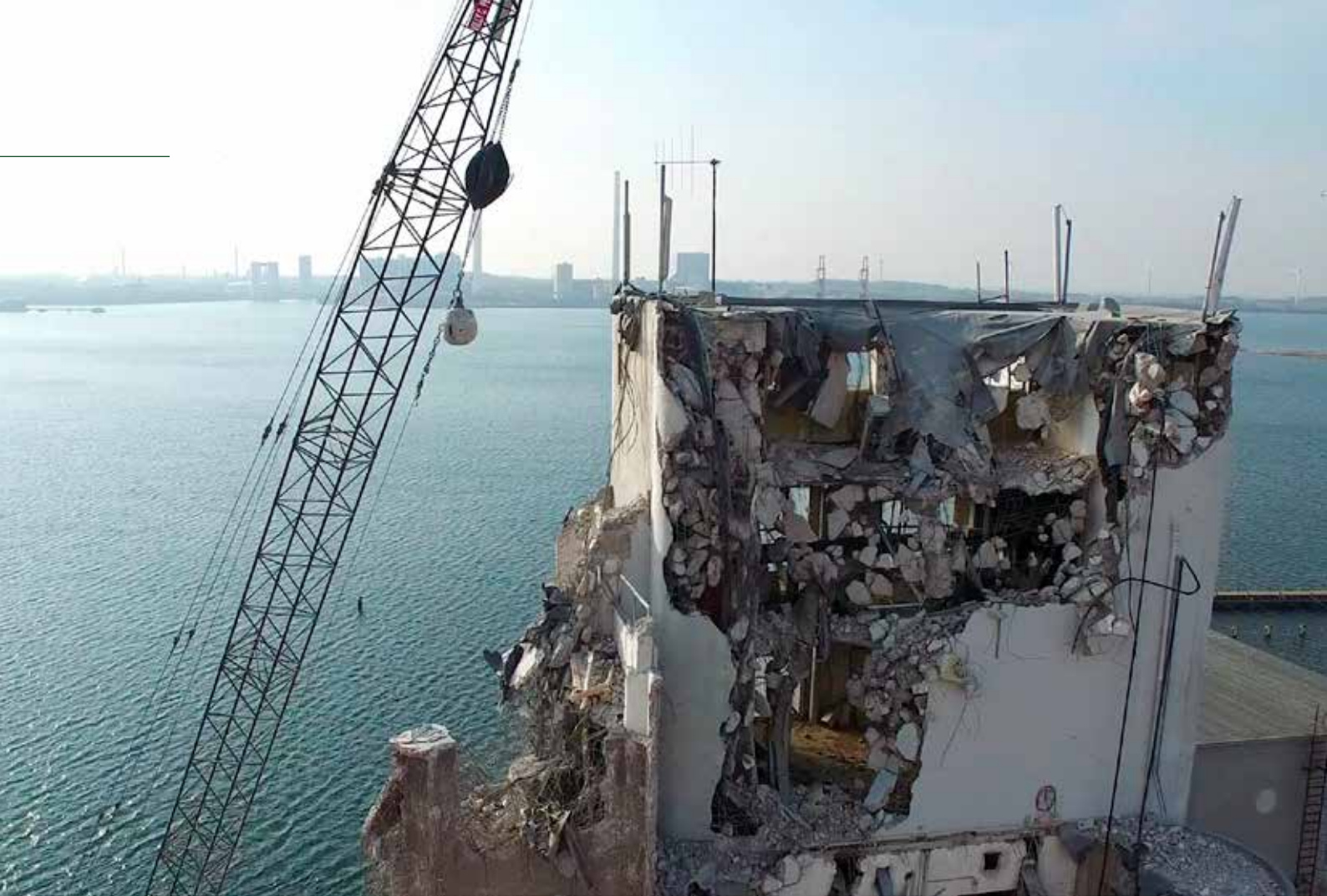
Nedbrydning af DLG-siloen i Kalundborg
