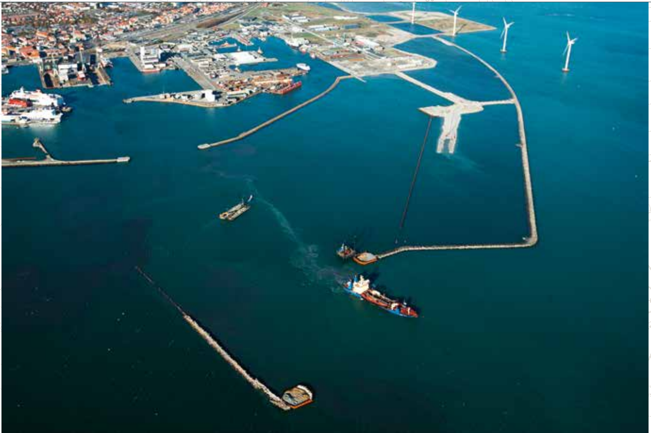
Det er specialisterne fra Aarsleff-koncernen, som står for udvidelsen af Frederikshavn Havn. I alt bliver 640.000 tons sten leveret og indbygget.
