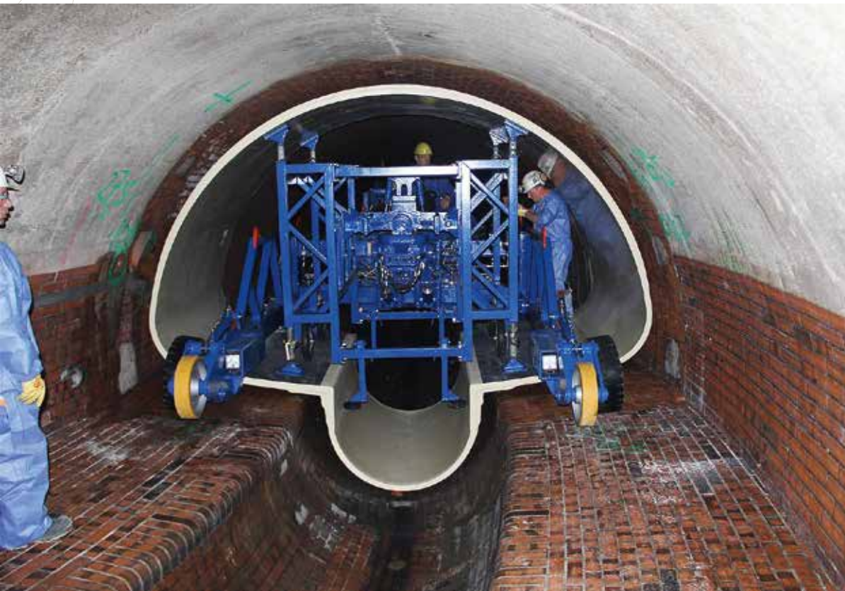
Under Den Olympiske Park i München renoverer Aarsleff en mere end 100 år gammel ledning med GRP-profiler. Den imponerende konstruktion er 4,2 meter bred og 3,35 meter høj.
